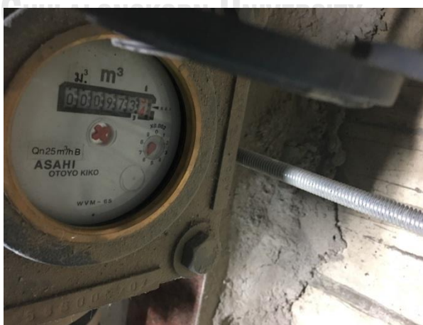
ภาพที่ 4 - 2 มิเตอร์ย่อยเพื่อตรวจวัดปริมาณการใช้น้ำแต่ละพื้นที่
