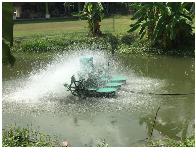
ภาพที่ 4 - 5 การบำบัดน้ำเสียที่ได้จากการอาบน้ำ
