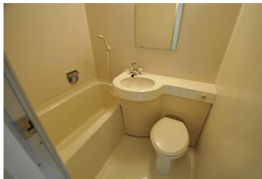
รูปภาพ 12 ตัวอย่างห้องน้ำสำเร็จในญี่ปุ่น
