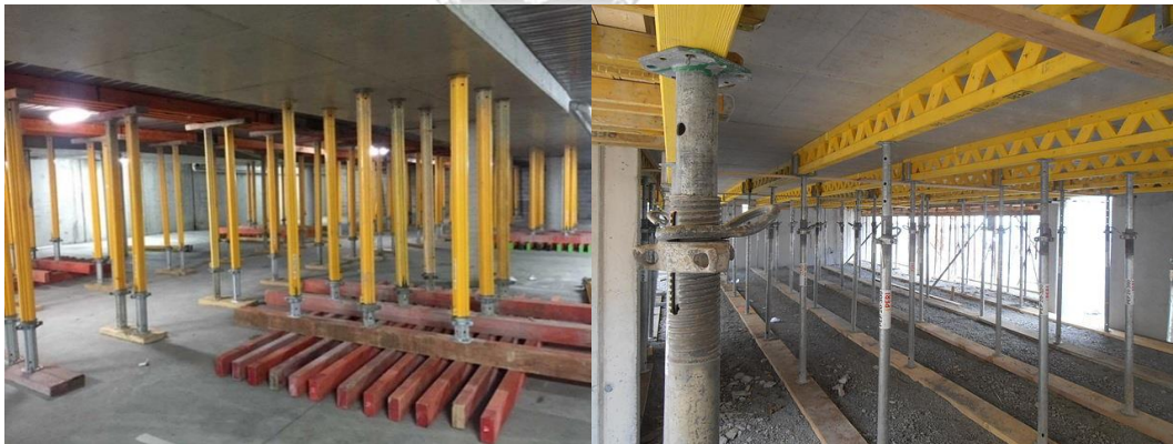
รูปที่ 70 โครงสร้างรับน้ำหนักชั่วคราว
