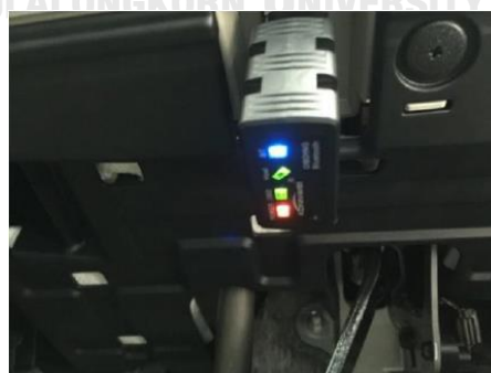
รูปที่ 26 การติดตั้ง OBD II ในรถ
