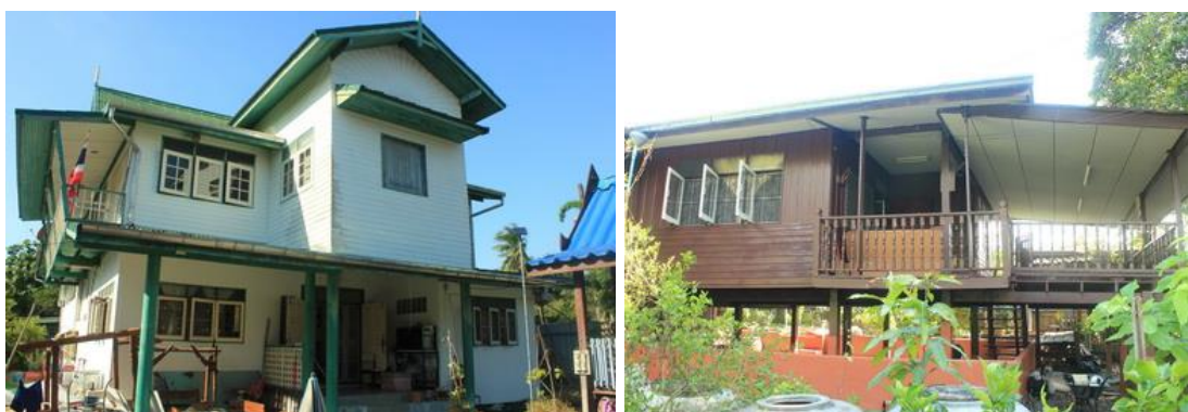
รูปภาพที่ 4.8 แสดงบ้านครึ่งก่ออิฐครึ่งไม้และบ้านไม้
