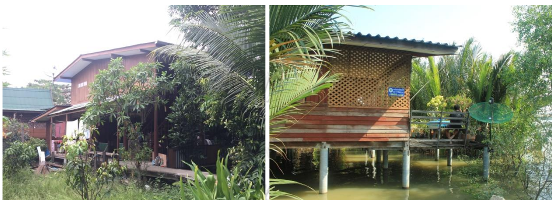
รูปภาพที่ 4.7 แสดงบ้านพักที่ไม่ติดแม่น้ำและติดน้ำ
