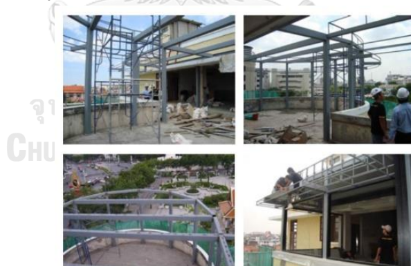
รูปที่ 14 วิธีการต่อเติมจุดชมวิวชั้นดาดฟ้า ที่มา: บริษัท ไรท์แมน จำกัด
