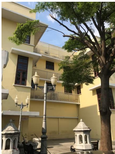
รูปที่ 11 การติดตั้งระแนงด้านหลังอาคาร
