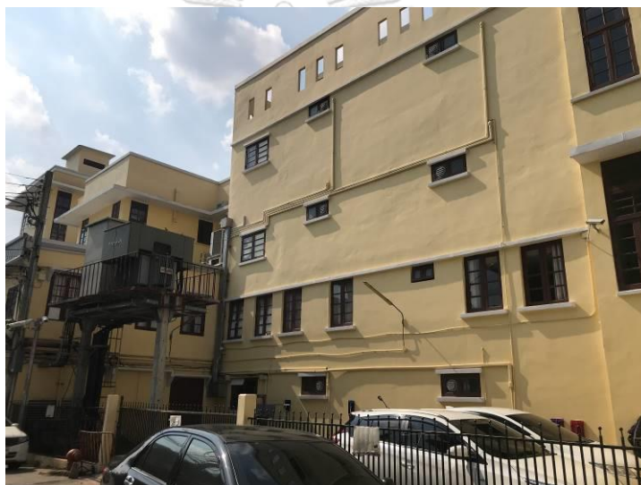
รูปที่ 10 ด้านหลังอาคารบริเวณที่มีการต่อเติม
