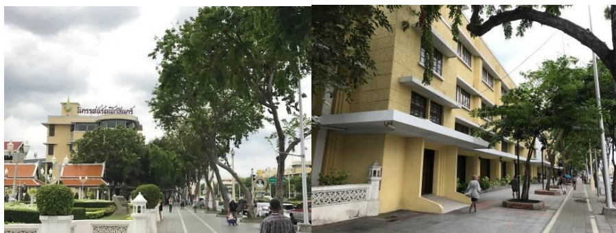
รูปที่ 4 อาคารนิทรศน์รัตนโกสินทร์ มุมมองจากภายนอก
