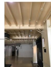
การดัดแปลงอาคาร : โครงสร้างเหล็ก คาน WF ติดกับโครงสร้างเสาเดิม
