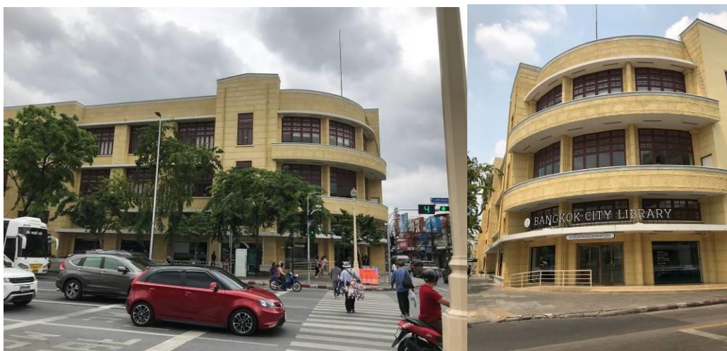
รูปที่ 18 อาคารหอสมุดเมืองกรุงเทพมหานคร
