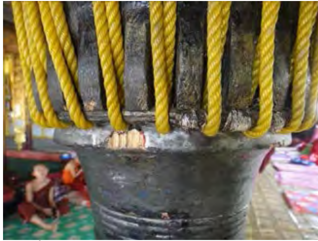
ภาพที่ ๔๖๐ เล็บช้างและการร้อยสายดิ่งแรงเสียดงร่องเล็บช้าง
