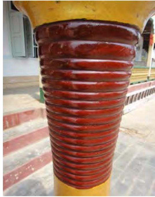
ภาพที่ ๓๘๙ การควั่นรอยลูกแก้ว แบบลอยนูน ของท่านเจ้าอาวาสวัดพระธาตุปู่จูง
