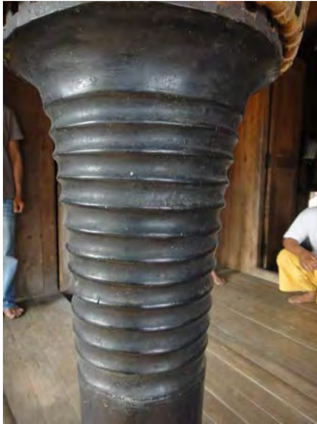
ภาพที่ ๓๒๒ แสดงการควั่นบากรอยลูกแก้วจากฐานโหลงสู่เอวกลองบ้านนางจำ
