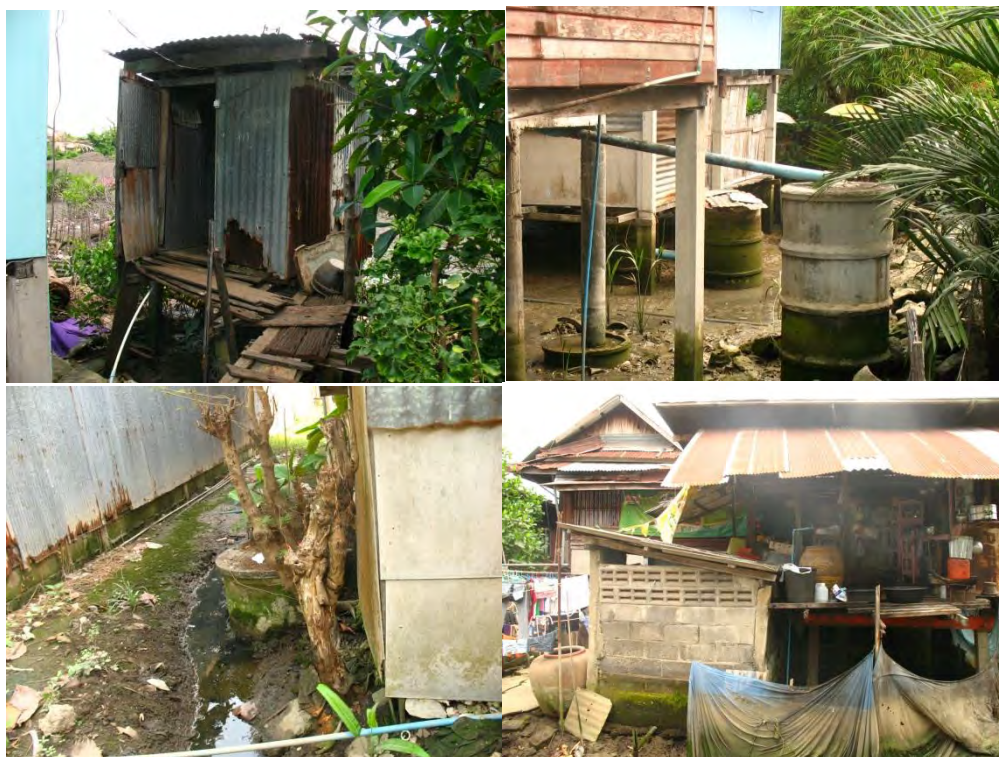
ภาพที่ 55 ส้วม การบำบัดของเสียและการระบายน้ำไม่ถูกสุขลักษณะ
