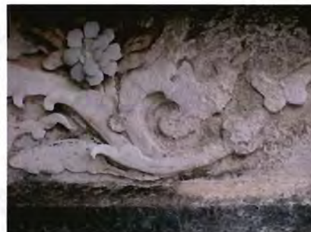
ภาพ ๔.๖๑ ลายก้านพฤษชาติ มีร่องรอยเนื้อ ปูนเสื่อมสภาพจากการกัดกร่อนของไอน้ำเค็ม ทำให้สีและปูนหลุดล่อน
