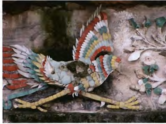
ภาพ ๔.๕๗ บริเวณคอสองทิศเหนือ ลายรูปหงส์ ส่วนปูน ปั้นและกระเบื้องเคลือบสีแตกหัก หลุด สีและปูนฉาบ เสื่อมสภาพ กะเทาะหลุด มีตะไคร่น้ำจับ
