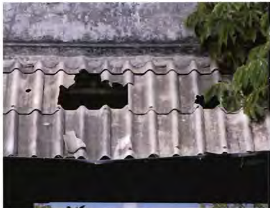
ภาพ ๔.๖๘-๔.๖๙ หลังคากระเบื้องซีเมนต์ใยหินแตก เป็นรูรั่ว ช่วงกันสาดปีกนกด้านทิศตะวันตก ซึ่งเป็นจุดที่รั่วเสียหายมากที่สุดในตัวอาคาร
