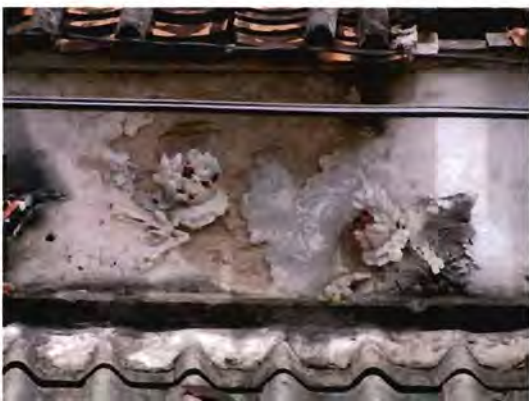
ภาพ ๔.๕๑ ปูนฉาบและสีกะเทาะหลุดล่อนมีคราบดำ
