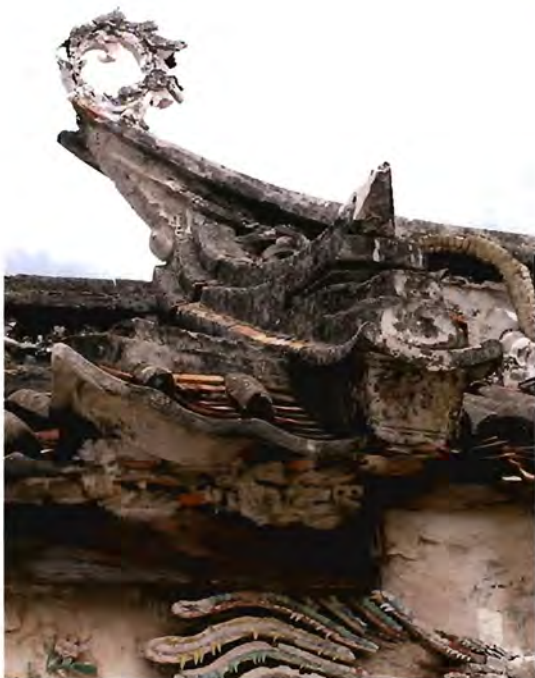
ภาพ ๔.๓๒ ชายหลังคาจั่วชั้นบน มีการออกซุดหลังคาเล็ก ส่วนปลายชายคาจั่วชั้นบนสุด ไม่มีเชิงกลอน ซึ่งน่าจะหลุดหายไป
