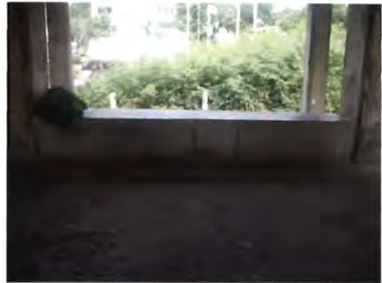
ภาพ ๔.๙๘-๔.๙๙ แท่นประทับก่ออิฐฉาบปูน มีสภาพสมบูรณ์ ทรุดโทรมตามอายุอาคารเพียงเล็กน้อย
