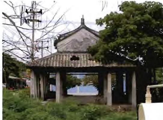
ภาพ ๔.๑๓ รูปด้านหลังอาคารด้านทิศตะวันออก
