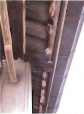
ภาพ ๔.๑๑๔ ปลายจันทัน เดิม ชั้นหลังคาปีกนกด้านทิศ ตะวันออกมีร่องรอยโดนไฟ ไหม้
