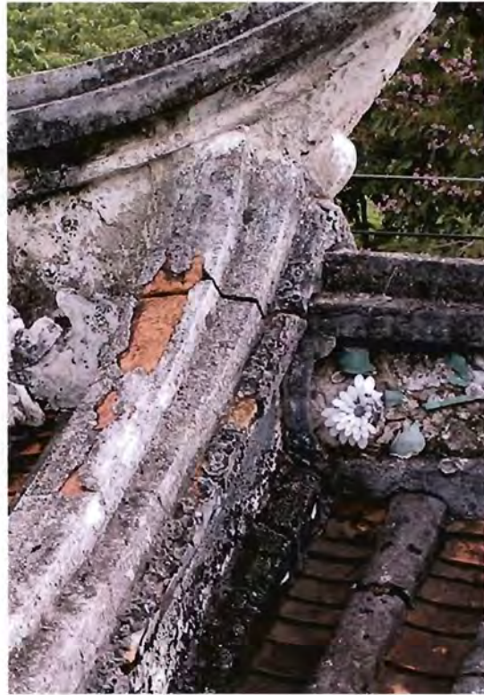
ภาพ ๔.๓๐-๔.๓๑ ส่วนปิดจั่วปูนปั้น แตกหักรุนแรง เนื้อปูนเสื่อมเกาะเกาะหลุดล่อนเป็นคราบดำ รวมไปถึงส่วนผนังหน้าจั่ว
