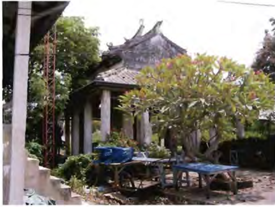
ภาพ ๔.๑๐ สภาพแวดล้อมอาคารในปัจจุบัน ขาดการดูแล มีร้านค้า เก็บของ เกิดความสกปรก เสียทัศนียภาพ
