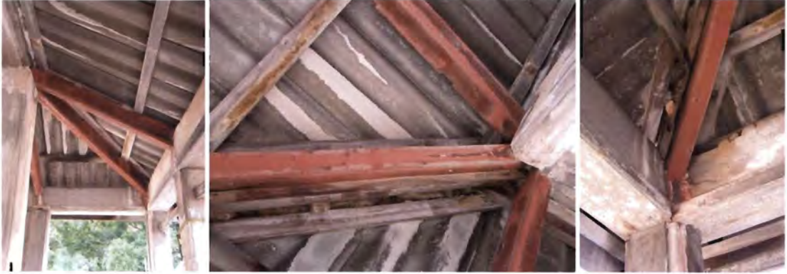
ภาพ ๔.๑๑๑-๔.๑๑๓ บริเวณมมตะเข้สั้น เห็นตัวไม้กลอนชำรุดมาก ไม้เสื่อม สวนตัวแปและจันทันมีสภาพยังพอใช้ การได้
