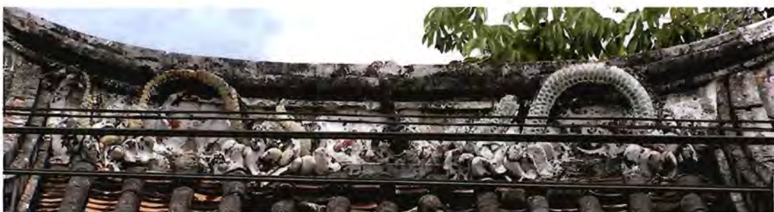
ภาพ ๔.๒๖ ผนังสันหลังคาเป็นลายปูนปั้น เขียนสีประดับกระเบื้องเคลือบสีรูปมังกร ซึ่งกระเบื้องแตกหักจำนวนมาก
