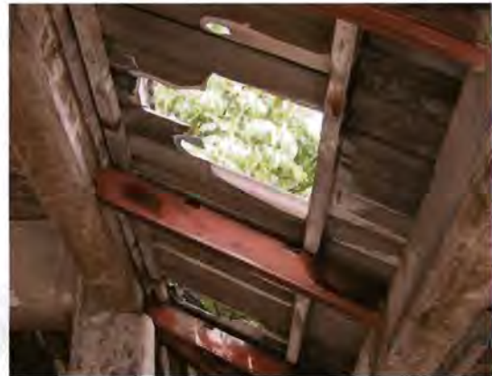
ภาพ ๔.๖๘-๔.๖๙ หลังคากระเบื้องซีเมนต์ใยหินแตก เป็นรูรั่ว ช่วงกันสาดปีกนกด้านทิศตะวันตก ซึ่งเป็นจุดที่รั่วเสียหายมากที่สุดในตัวอาคาร
