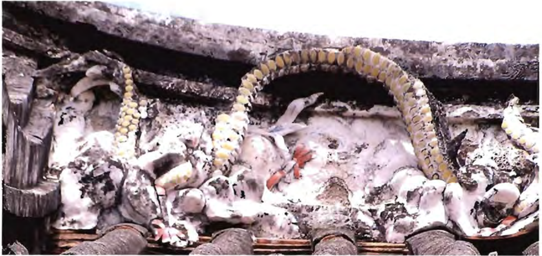
ภาพ ๔.๒๓ รูปขยายลายปูนปั้นด้านทิศใต้ แสดงจุดที่เนื้อปูนกะเทาะเป็นรอย และการแตกหักของตัวลาย
