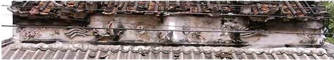
ภาพ ๔.๔๘ ผนังคอสองด้านทิศใต้ของอาคาร
