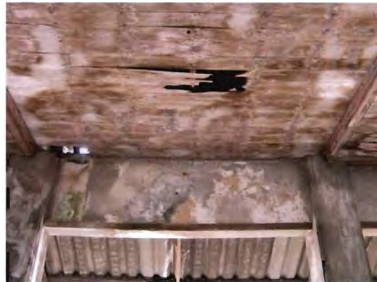
ภาพ ๔.๙๖-๔.๙๗ ผนังคอสองภายใน สีและปูนฉาบเสียหาย หลุดล่อน มีคราบดำและคราบตะไคร่น้ำเกิดจากน้ำฝนรั่ว
