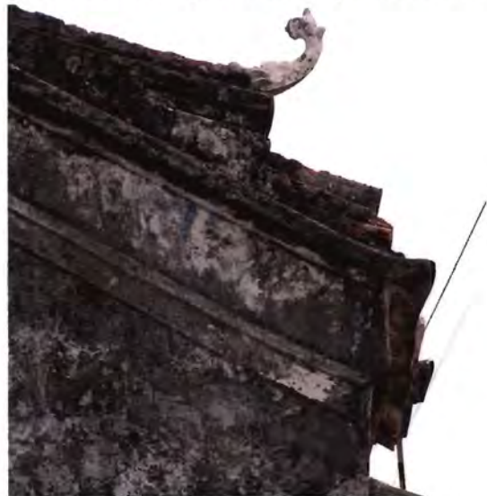
ภาพ ๔.๔๗ ปลายตัวครอบปิดหน้าจั่วประดับปูนปั้น ซึ่งแตกหักไปเกือบหมด ส่วนผนังหน้าจั่วเห็นร่องรอยการเขียนสี ซึ่งลบเลือนไป จากการเสื่อมและหลุดล่อนของปูน
