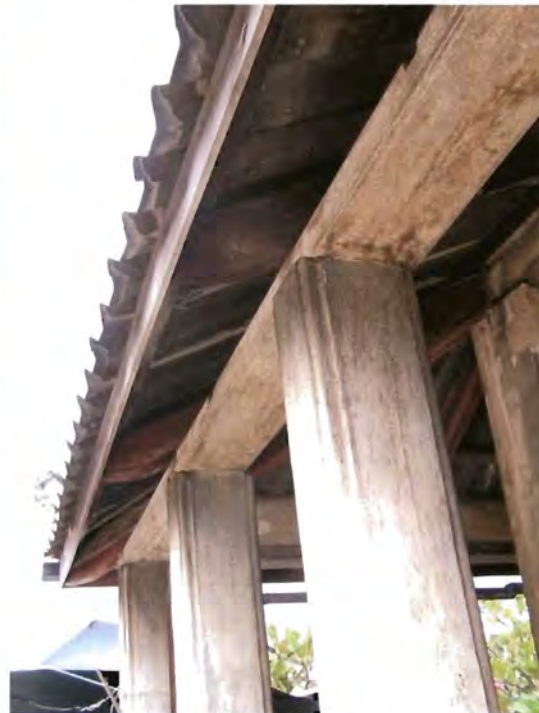
ภาพ ๔.๑๑๐ จันทันไม้เก่าพาดบนคานทับหลังไม้ และยื่นปลายจันทันยึดกับเชิงกลอน
