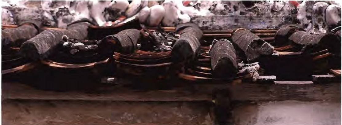
ภาพ ๔.๓๕ ส่วนครอบกระเบื้องเนื้อปูนเสื่อมสภาพ แตกหัก ไม่สามารถยึดทับกระเบื้องได้
