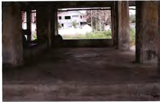
ภาพ ๔.๑๐๒ พื้นซีเมนต์ขัดหยาบภายในห้องเสารอบใน สภาพสมบูรณ์พอใช้ มีรอยกะเทาะหลุดล่อน เล็กน้อย
