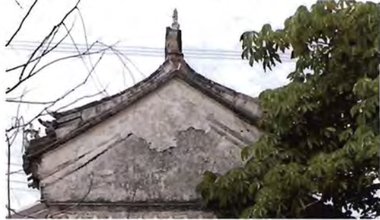
ภาพ ๔.๔๔-๔.๔๕ หน้าจั่วก่ออิฐฉาบปูนปั้นลาย ด้านหน้าและด้านหลังอาคาร รอยปูนเสื่อมสภาพ หลุดล่อน มีคราบดำ
