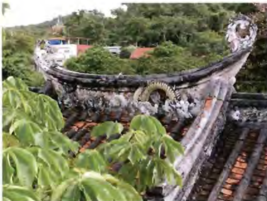
ภาพ ๔.๒๔ ครอบสันหลังคาปูนปั้นด้านทิศเหนือ มีร่องรอยปูนเสื่อมสภาพ หลุดล่อน เป็นคราบดำ
