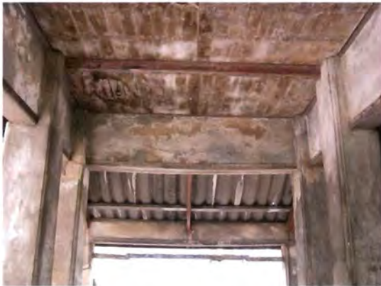
ภาพ ๔.๙๖-๔.๙๗ ผนังคอสองภายใน สีและปูนฉาบเสียหาย หลุดล่อน มีคราบดำและคราบตะไคร่น้ำเกิดจากน้ำฝนรั่ว
