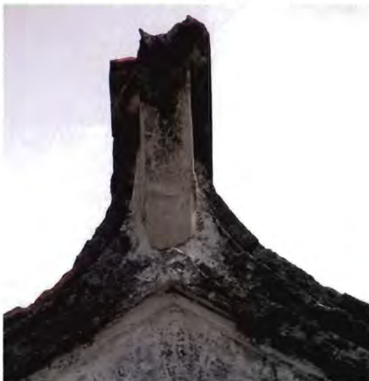
ภาพ ๔.๔๖ ยอดจั่วแตกหัก ชำรุด ปูนเสื่อมหลุดล่อน เป็นคราบดำ
