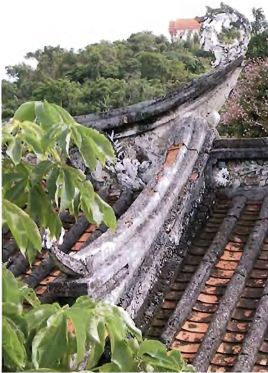
ภาพ ๔.๓๐-๔.๓๑ ส่วนปิดจั่วปูนปั้น แตกหักรุนแรง เนื้อปูนเสื่อมเกาะเกาะหลุดล่อนเป็นคราบดำ รวมไปถึงส่วนผนังหน้าจั่ว
