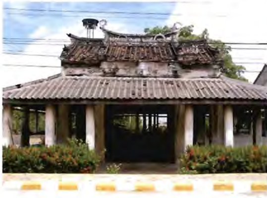
ภาพ ๔.๑๒ รูปด้านข้างอาคารด้านทิศใต้
