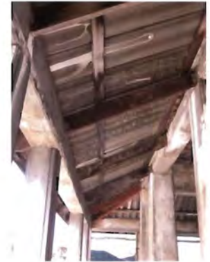
ภาพ ๔.๑๑๖ จันทันไม้ตัวใหม่ ด้านทิศใต้ของตัวอาคาร สภาพใช้การได้ดี
