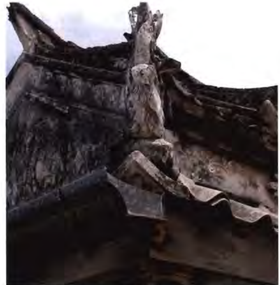
ภาพ ๔.๖๕ รางน้ำสังกะสีติดตั้งใหม่ ๓ ด้าน ยกเว้นด้านทิศใต้
