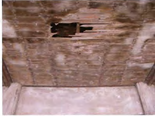
ภาพ ๔.๙๓ รูรั่วขนาดใหญ่สุด บริเวณกลางฝ้า
