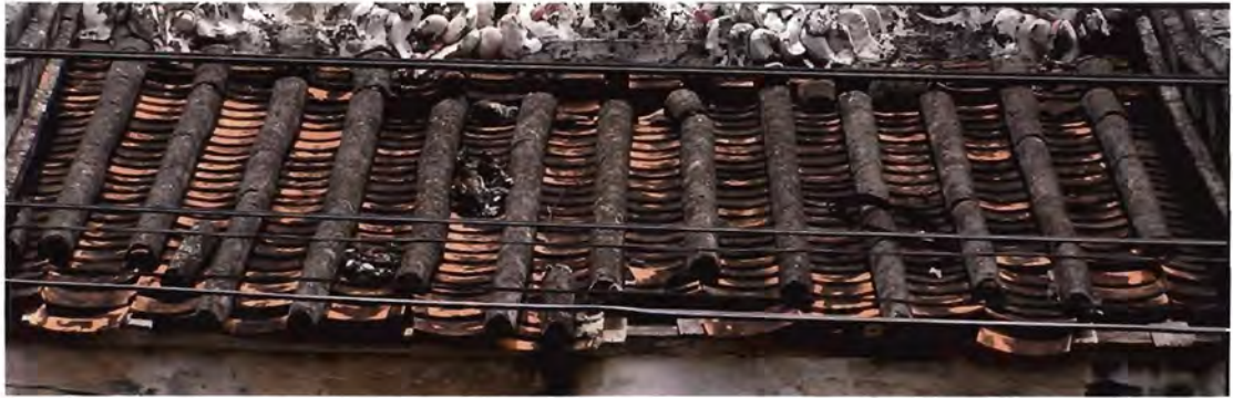
ภาพ ๔.๓๔ กระเบื้องกาบูนสภาพเก่าแตกหัก หลุด เป็นรูรั่ว ส่วนครอบกระเบื้องแนวตั้งเนื้อปูนเสื่อมแตกหัก
