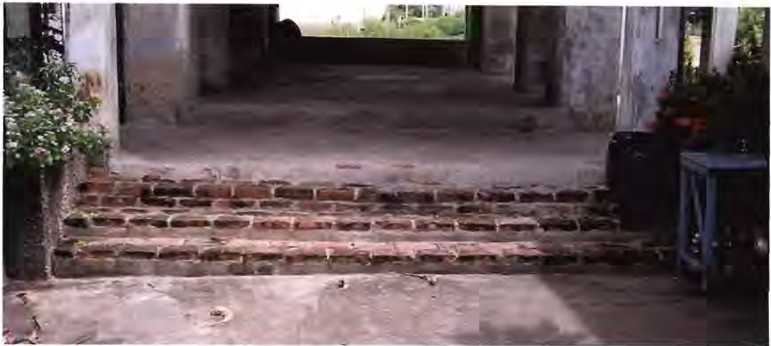
ภาพ ๔.๑๐๖ บันไดทางขึ้นหน้าอาคารด้านทิศตะวันตก
