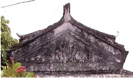
ภาพ ๔.๔๔-๔.๔๕ หน้าจั่วก่ออิฐฉาบปูนปั้นลาย ด้านหน้าและด้านหลังอาคาร รอยปูนเสื่อมสภาพ หลุดล่อน มีคราบดำ
