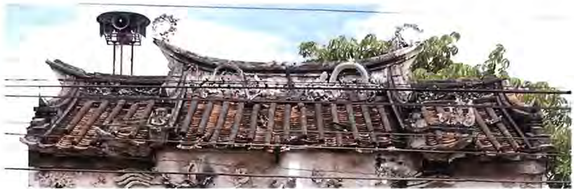
ภาพ ๔.๒๑ สภาพหลังคาชั้นบน ทรงจั่วซ้อน ๒ ชั้น รูปแบบสถาปัตยกรรมจีน
