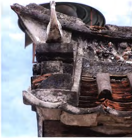
ภาพ ๔.๔๒ ส่วนหน้าครอบปิดจั่วหลังคาชั้นล่างตกแต่งลายปูนปั้นเขียนสีซึ่งเลือนหายไปและปูนแตกกะเทาะหลุด
