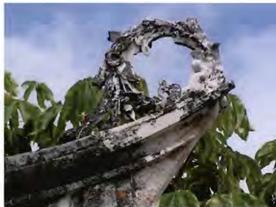
ภาพ ๔.๒๕ ปูนปั้นรูปหัวมังกรคายก้านลายพฤกษชาติ ประดับยอดครอบสันหลังคา หักชำรุด เป็นคราบดำ
