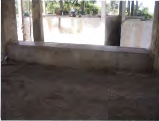
ภาพ ๔.๙๘-๔.๙๙ แท่นประทับก่ออิฐฉาบปูน มีสภาพสมบูรณ์ ทรุดโทรมตามอายุอาคารเพียงเล็กน้อย
