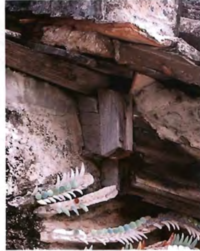
ภาพ ๔.๑๐๘ ปลายจันทันไม้เก่ายื่นออกนอกตัวอาคารเล็กน้อย เพื่อยึดกับเชิงกลอน (ในภาพ เชิงกลอนหลุดหายไป)
