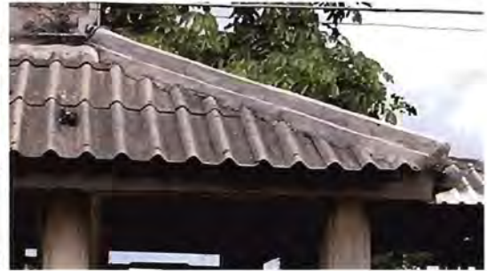
ภาพ ๔.๖๓ กันสาดปีกนกด้านทิศใต้ หลังอาคาร ทำครอบตะเข้สันปูนใหม่
