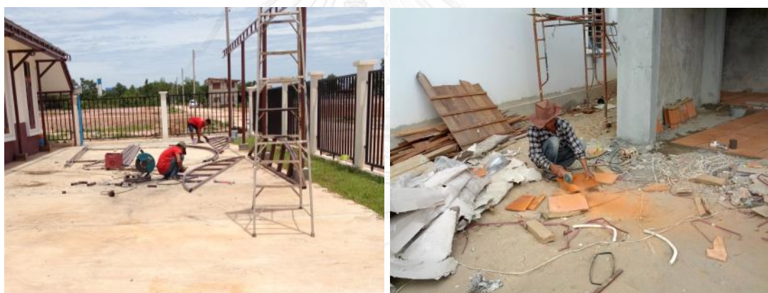
รูปที่ 4.15 ตัวอย่างอุปกรณ์ที่ใช้ในงานตัดโลหะและงานตัดกระเบื้อง
