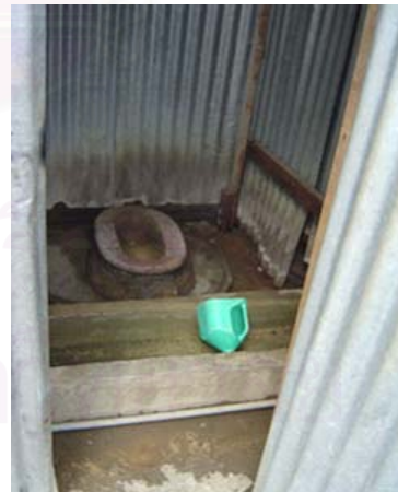
รูปที่ 25.6 ห้องส้วม
