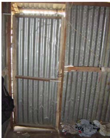
รูปที่ 21.5 ประตูห้องที่พักอาศัย
