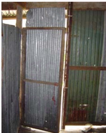
รูปที่ 16.5 ประตูห้องที่พักอาศัย
