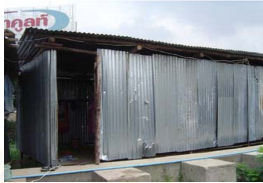
รูปที่ 2.2 ทางเดินบริเวณที่พักอาศัย
