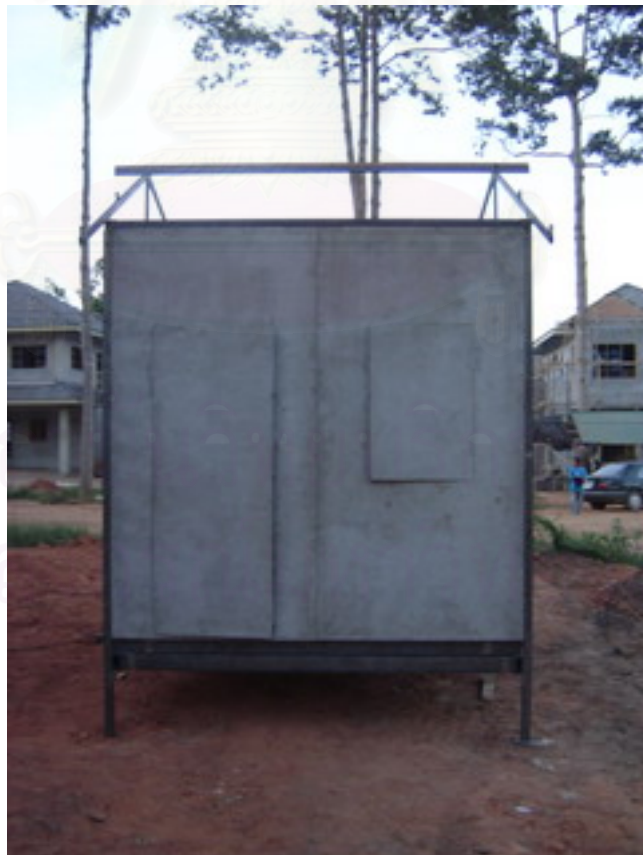
รูปที่ 5.32 ติดตั้งโครงหลังคา
