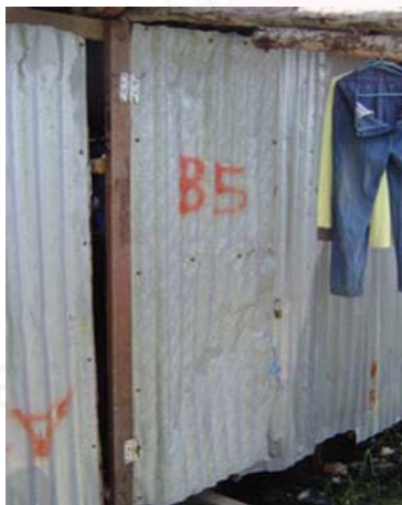
รูปที่ 8.5 ประตูห้องที่พักอาศัย
