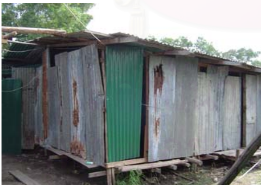
รูปที่ 22.5 ประตูห้องที่พักอาศัย
