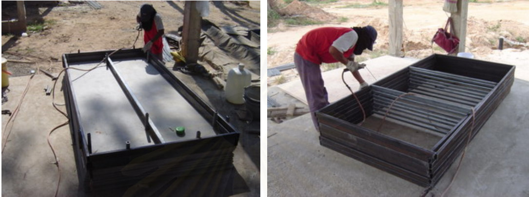
รูปที่ 5.21 ประกอบโครงพื้นและผนัง
