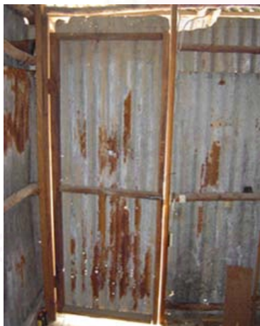
รูปที่ 30.5 ประตูห้องที่พักอาศัย
