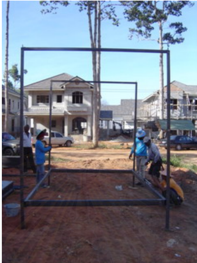
รูปที่ 5.23 ประกอบเสากับคานโดยใช้สลักเกลียวยึด
