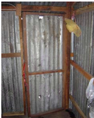
รูปที่ 18.5 ประตูห้องที่พักอาศัย
