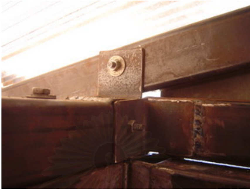
รูปที่ 5.35 การต่อยึดจันทันกับอะเสและซื่อ
