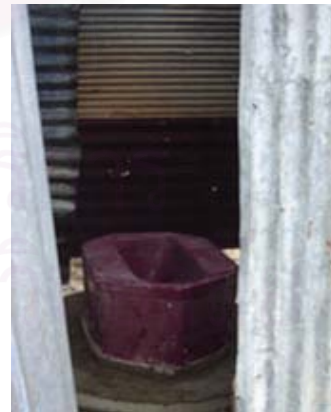
รูปที่ 7.6 ห้องส้วม
