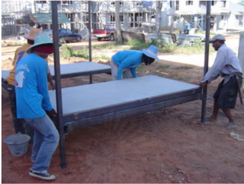
รูปที่ 5.25 ติดตั้งโครงพื้น
