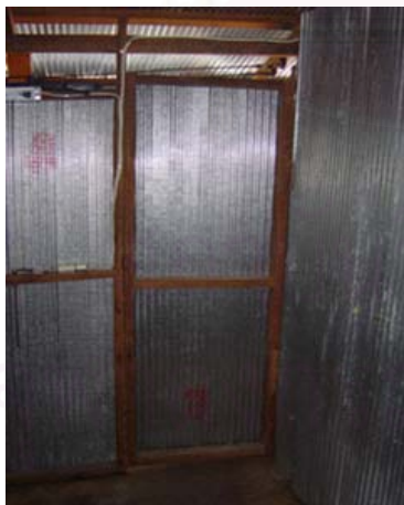
รูปที่ 32.5 ประตูห้องที่พักอาศัย
