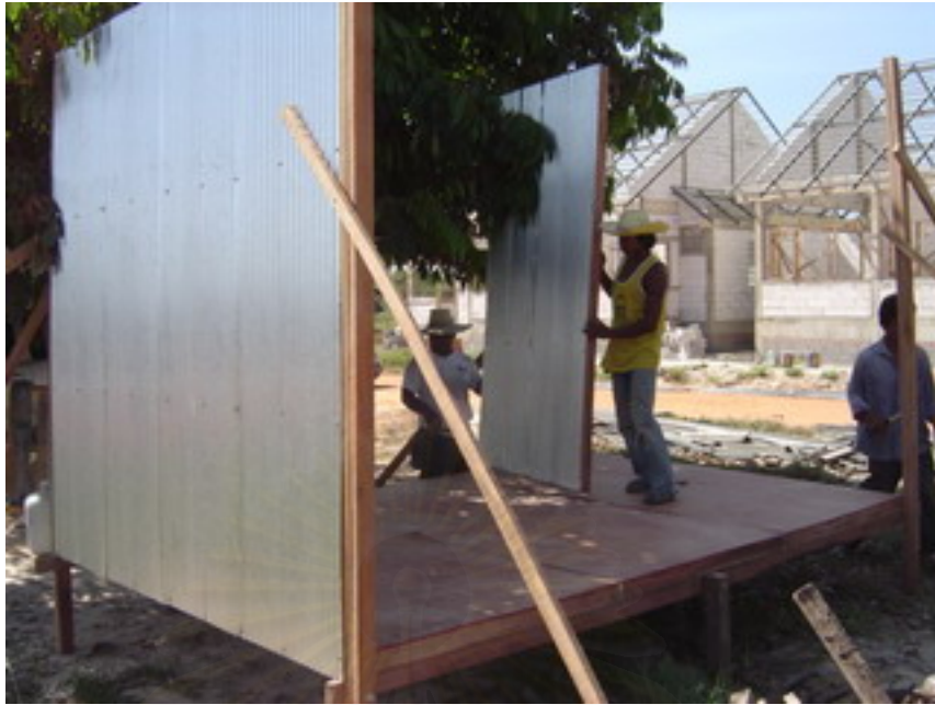
รูปที่ 5.9 ติดตั้งโครงพื้นและโครงผนัง
