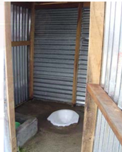
รูปที่ 1.6 ห้องส้วม
