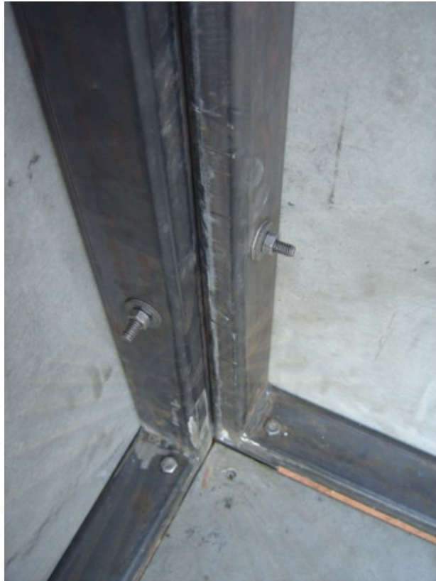
รูปที่ 5.29 การต่อยึดระหว่างโครงผนังกับเสาและโครงพื้น
