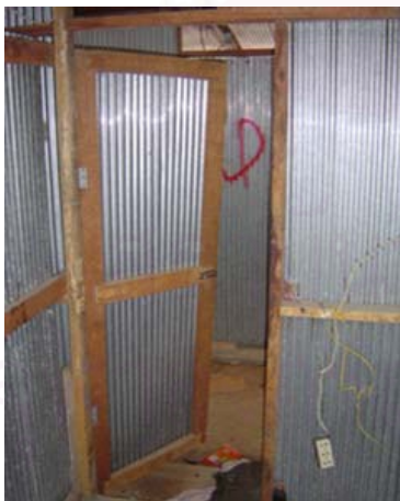
รูปที่ 23.5 ประตูห้องที่พักอาศัย
