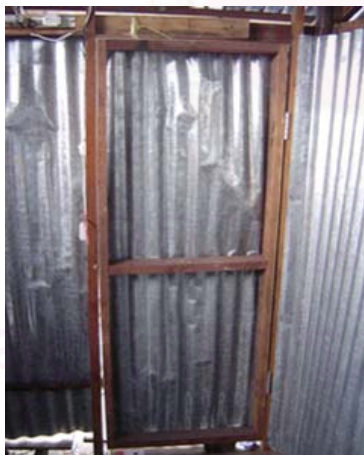
รูปที่ 14.5 ประตูห้องที่พักอาศัย
