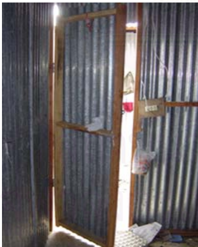
รูปที่ 1.5 ประตูห้องที่พักอาศัย
