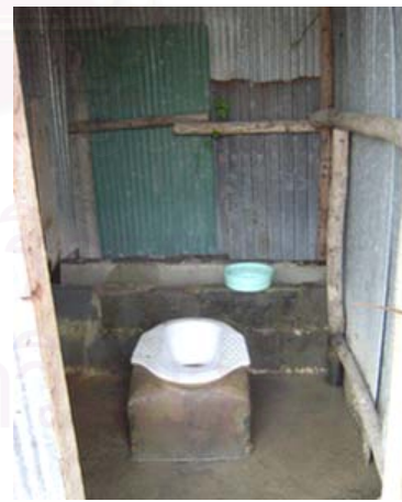
รูปที่ 16.6 ห้องส้วม
