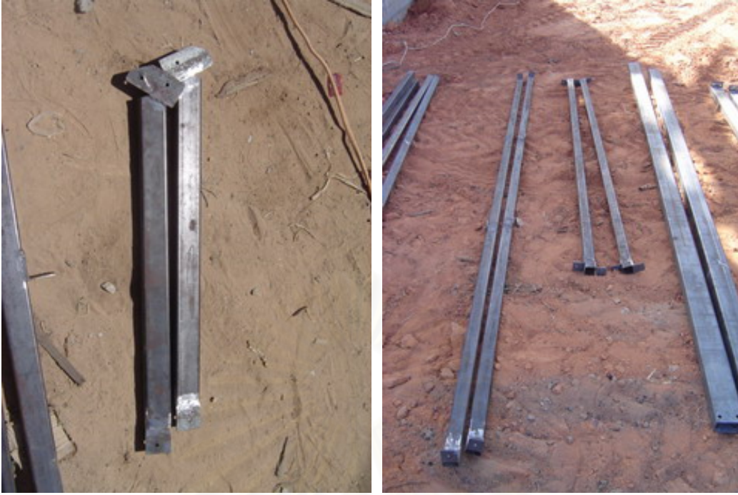
รูปที่ 5.19 เหล็กโครงหลังคา
