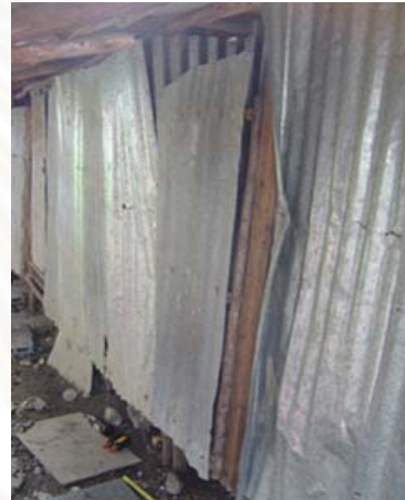
รูปที่ 10.4 ประตูห้องที่พักอาศัย
