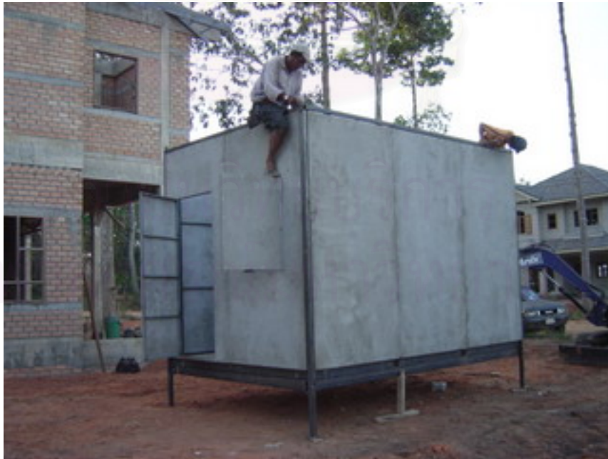
รูปที่ 5.30 ตรวจสอบการต่อยึดระหว่างโครงสร้าง
