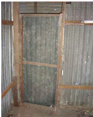
รูปที่ 28.5 ประตูห้องที่พักอาศัย
