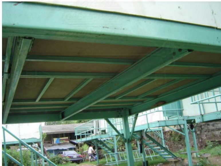
รูปที่ 4.4 โครงเหล็กพื้น
