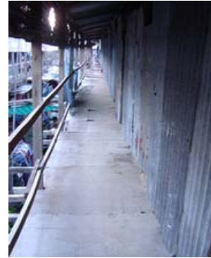
รูปที่ 28.2 ทางเดินบริเวณที่พักอาศัย
