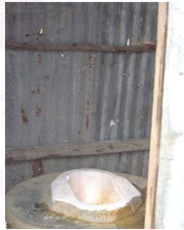
รูปที่ 26.6 ห้องส้วม
