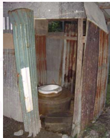
รูปที่ 19.6 ห้องส้วม
