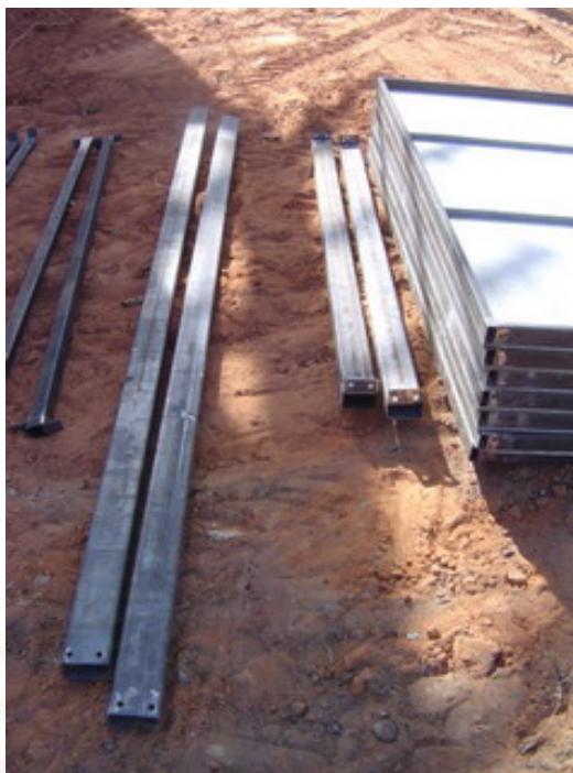
รูปที่ 5.16 คานอาคาร
