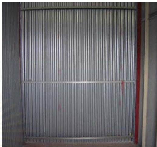
รูปที่ 33.8 ผนังภายในห้องพักอาศัย
