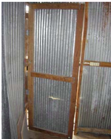
รูปที่ 13.5 ประตูห้องที่พักอาศัย
