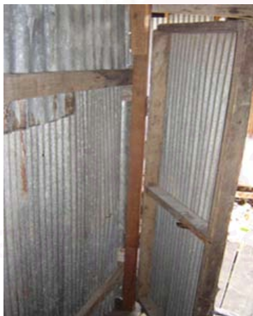
รูปที่ 12.5 ประตูห้องที่พักอาศัย
