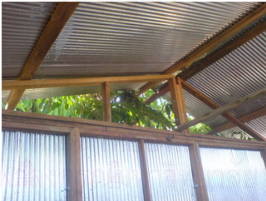
รูปที่ 5.12 ติดตั้งโครงหลังคาและมุงสังกะสี
