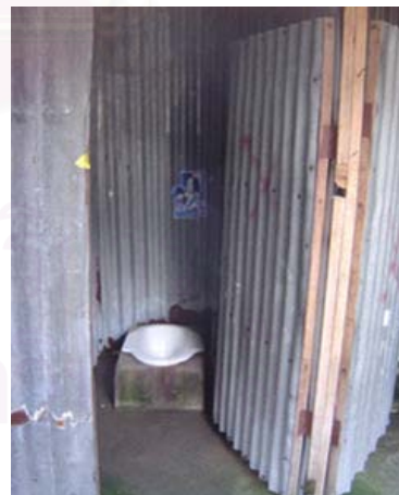
รูปที่ 15.6 ห้องส้วม
