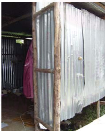
รูปที่ 2.5 ประตูห้องที่พักอาศัย
