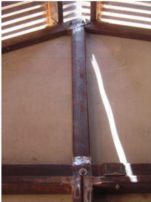
รูปที่ 5.34 การต่อยึดดั่งกับซื่อและจันทัน
