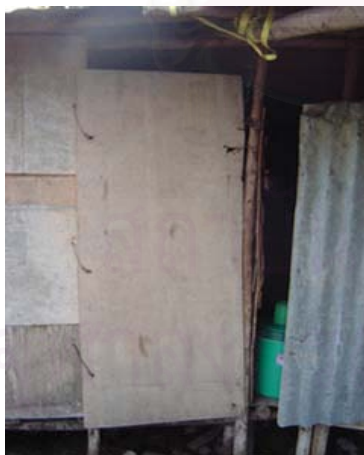
รูปที่ 24.5 ประตูห้องที่พักอาศัย
