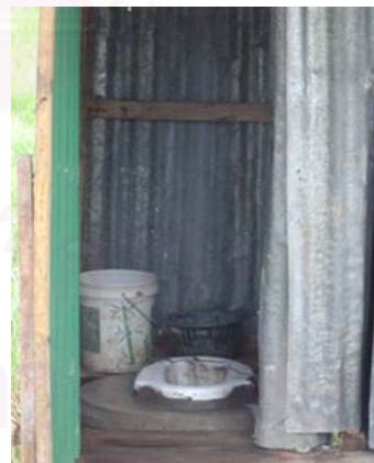
รูปที่ 22.6 ห้องส้วม
