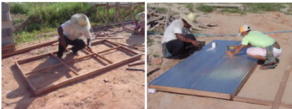
รูปที่ 5.6 ประกอบโครงพื้นและผนัง
