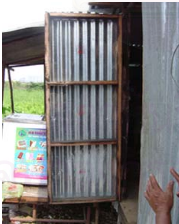
รูปที่ 26.5 ประตูห้องที่พักอาศัย
