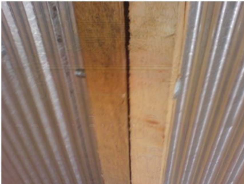
รูปที่ 5.10 ยึดโครงผนังด้วยสลักเกลียว
