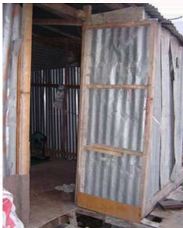
รูปที่ 19.5 ประตูห้องที่พักอาศัย
