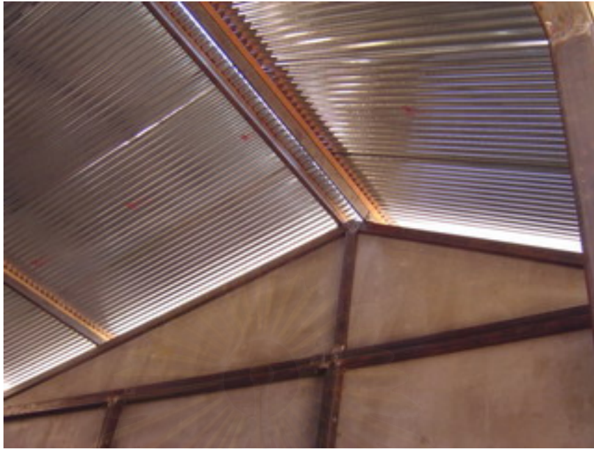
รูปที่ 5.33 มุงหลังคาและปิดจั่ว
