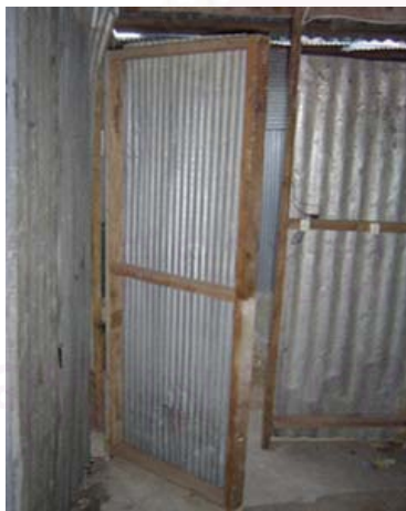
รูปที่ 5.5 ประตูห้องที่พักอาศัย
