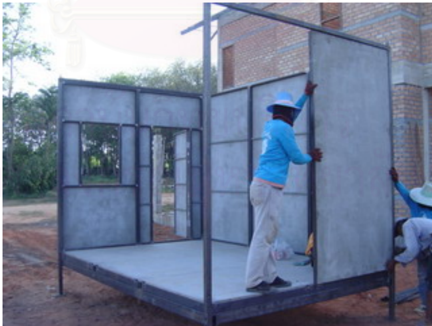
รูปที่ 5.28 ติดตั้งโครงผนัง
