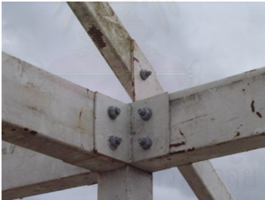
รูปที่ 4.29 รอยต่อระหว่างเสาชั้นบน คานอะเสและโครงหลังคา
