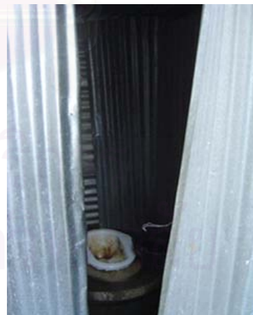
รูปที่ 14.6 ห้องส้วม
