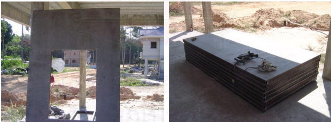
รูปที่ 5.22 ประกอบโครงผนังกับไม้อัดซีเมนต์
