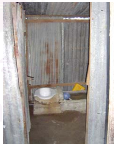
รูปที่ 5.6 ห้องส้วม
