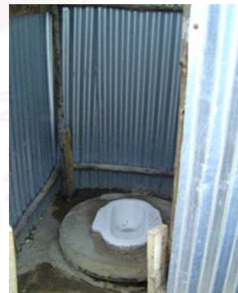
รูปที่ 4.6 ห้องส้วม
