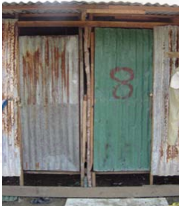
รูปที่ 11.5 ประตูห้องที่พักอาศัย
