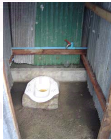
รูปที่ 18.6 ห้องส้วม
