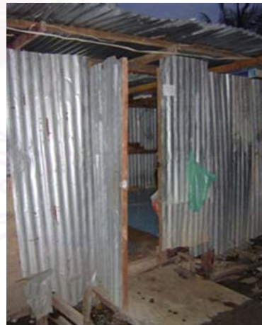
รูปที่ 3.6 ประตูห้องที่พักอาศัย
