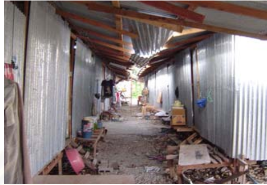
รูปที่ 29.2 ทางเดินบริเวณที่พักอาศัย
