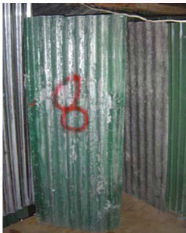
รูปที่ 31.5 ประตูห้องที่พักอาศัย
