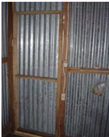
รูปที่ 29.5 ประตูห้องที่พักอาศัย
