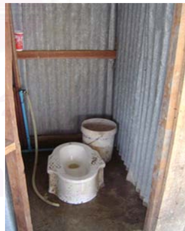
รูปที่ 11.6 ห้องส้วม
