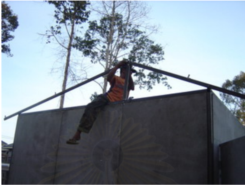
รูปที่ 5.31 ติดตั้งโครงหลังคา
