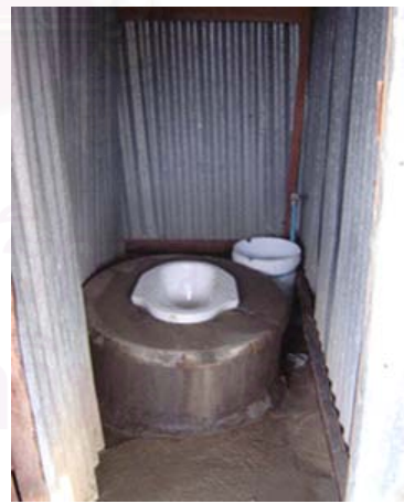
รูปที่ 17.6 ห้องส้วม
