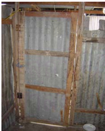
รูปที่ 20.5 ประตูห้องที่พักอาศัย
