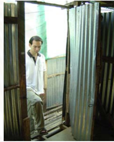
รูปที่ 4.4 ประตูห้องที่พักอาศัย
