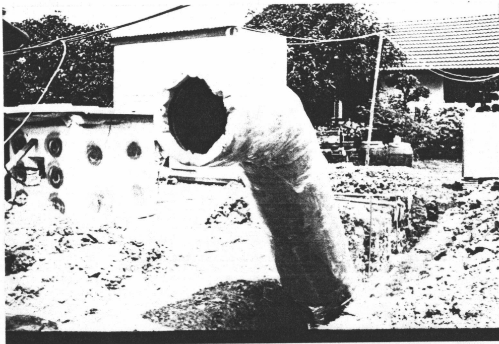
หุ้มฉนวนกันความร้อนไมโครไฟเบอร์ บริเวณท่อหลักที่อยู่พื้นเหนือพื้นดิน เพื่อป้องกันความร้อนจากแสงอาทิตย์
