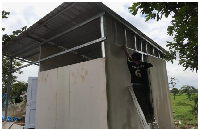
ภาพที่ 66 ติดตั้งผนัง
