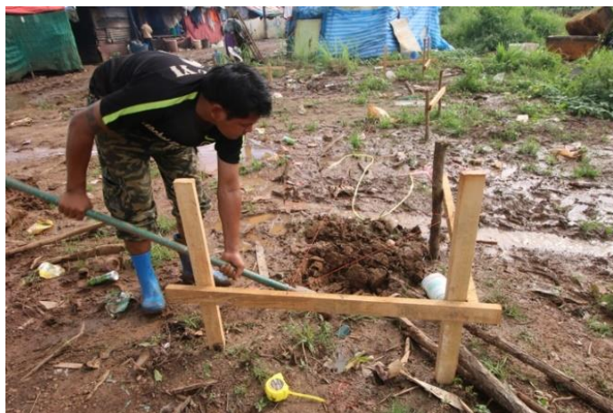
ภาพที่ 43 ขุดดินเพื่อเตรียมตั้งเสาตอม่อ
