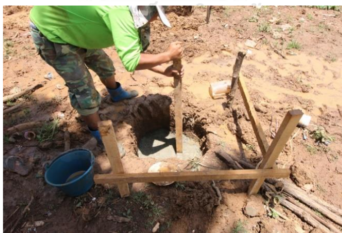
ภาพที่ 44 เทคอนกรีตหยาบ
