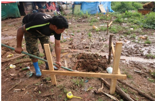
ภาพที่ 64 ขุดดินเพื่อเตรียมตั้งเสาตอม่อ
