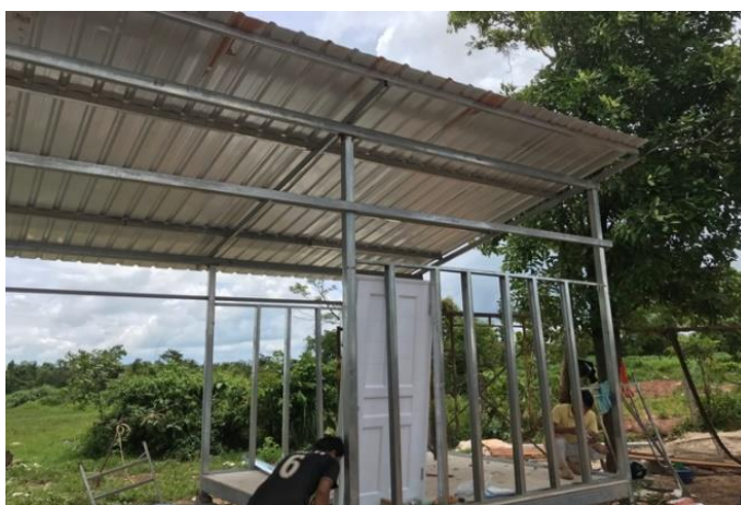
ภาพที่ 55 ติดตั้งโครงคร่าวผนัง
