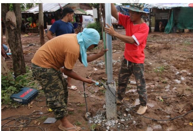
ภาพที่ 48 ติดตั้งเสาเหล็กบนตอม่อ
