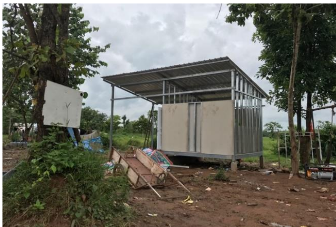
ภาพที่ 57 ติดตั้งผนังแผ่นไฟเบอร์ซีเมนต์
