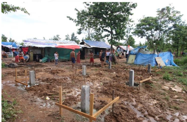
ภาพที่ 65 ติดตั้งเสาตอม่อ
