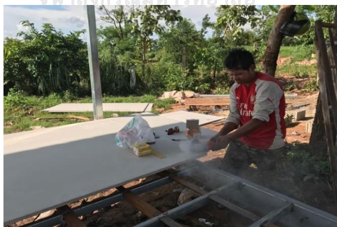
ภาพที่ 54 ติดตั้งแผ่นพื้นไฟเบอร์ซีเมนต์
