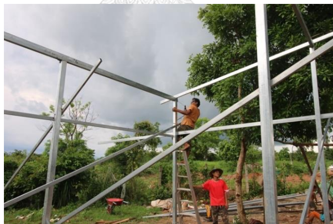
ภาพที่ 50 ติดตั้งจันทัน
