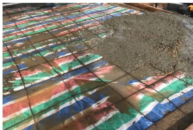
ภาพที่ 46 เทพื้นคอนกรีตภายนอกอาคาร
