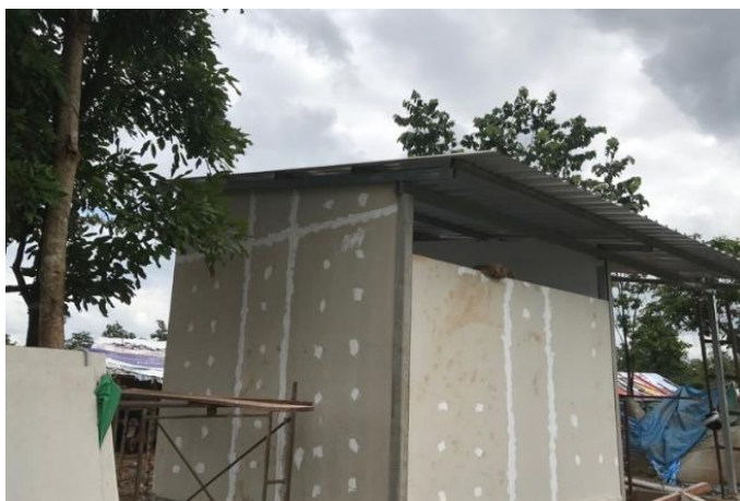
ภาพที่ 59 ฉาบปูนพลาสติกปิดรอยต่อและติดตั้งแผ่นปิดมุมไฟเบอร์ซีเมนต์
