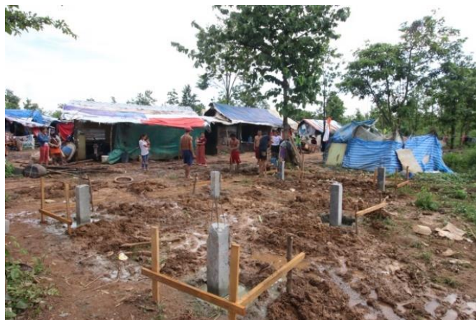
ภาพที่ 45 ติดตั้งเสาตอม่อ
