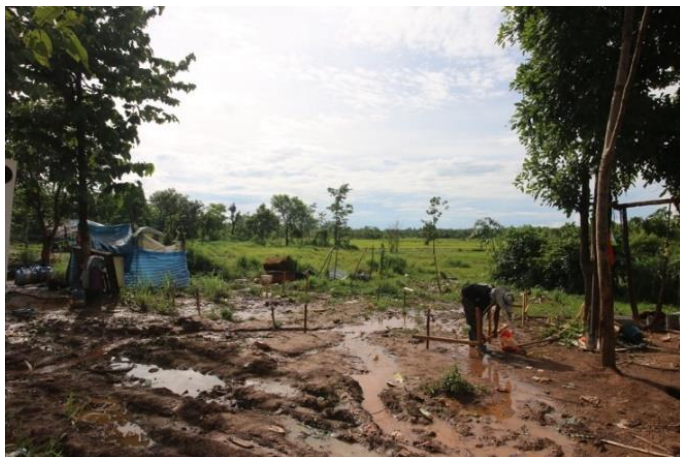
ภาพที่ 41 ปรับระดับพื้นที่ก่อสร้าง
