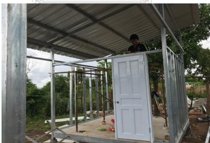
ภาพที่ 56 ติดตั้งประตู
