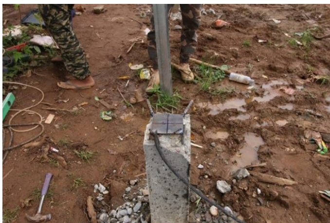
ภาพที่ 47 เชื่อมเพลทเหล็กกับเสาตอม่อ
