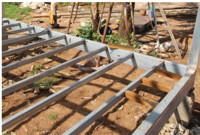
ภาพที่ 53 ติดตั้งคานและตง
