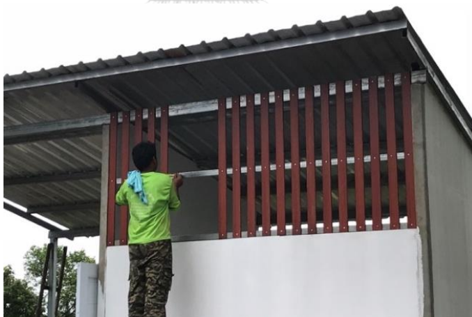
ภาพที่ 60 ติดตั้งแผงระแนง
