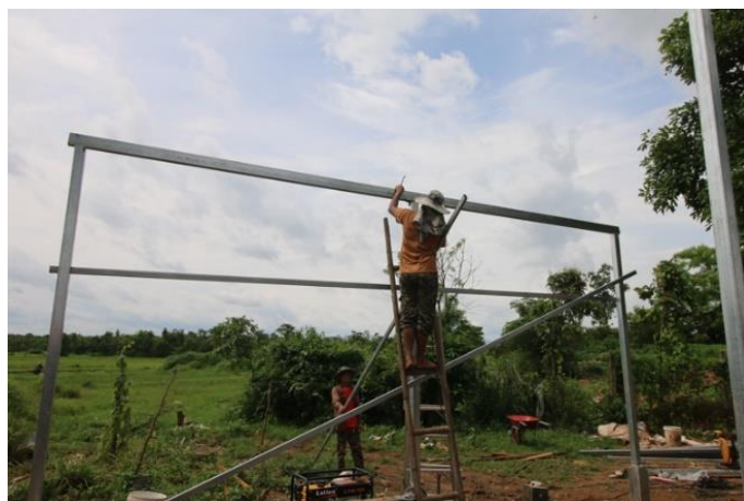
ภาพที่ 49 ติดตั้งอะเส
