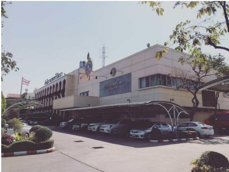
ภาพที่ 14 อาคารสำนักงานราชการเขตทวีวัฒนา (ถ่ายโดยผู้วิจัยเมื่อ 22 มกราคม 2562 ณ อาคารสำนักงานเขตทวีวัฒนา กรุงเทพมหานคร)
