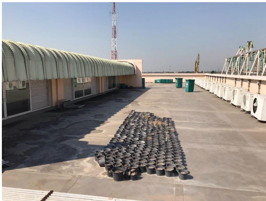
ภาพที่ 18 พื้นที่ชั้นดาดฟ้าอาคารสำนักงานเขตทวีวัฒนา (ถ่ายโดยผู้วิจัยเมื่อ 22 มกราคม 2562 ณ อาคารสำนักงานเขตทวีวัฒนา กรุงเทพมหานคร)
