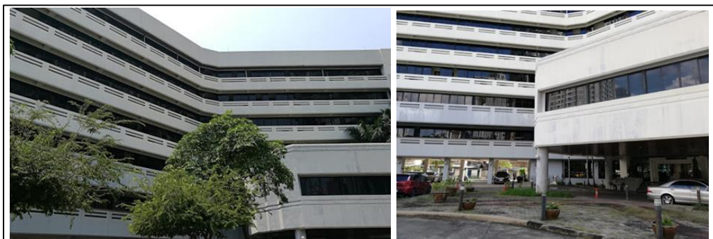
รูปภาพที่ 28 บริเวณภายนอกอาคารสำนักงานอัยการสูงสุด อาคารกรุงเทพใต้
