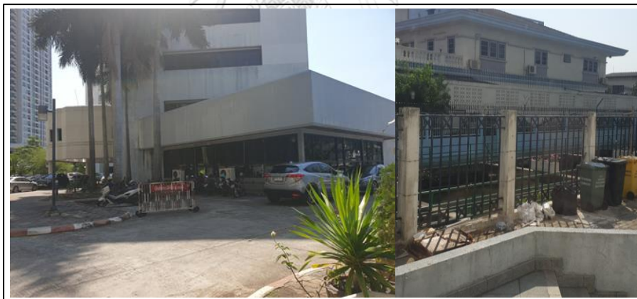
รูปภาพที่ 30 บริเวณภายนอกโดยรอบอาคารสำนักงานอัยการสูงสุด อาคารกรุงเทพใต้
