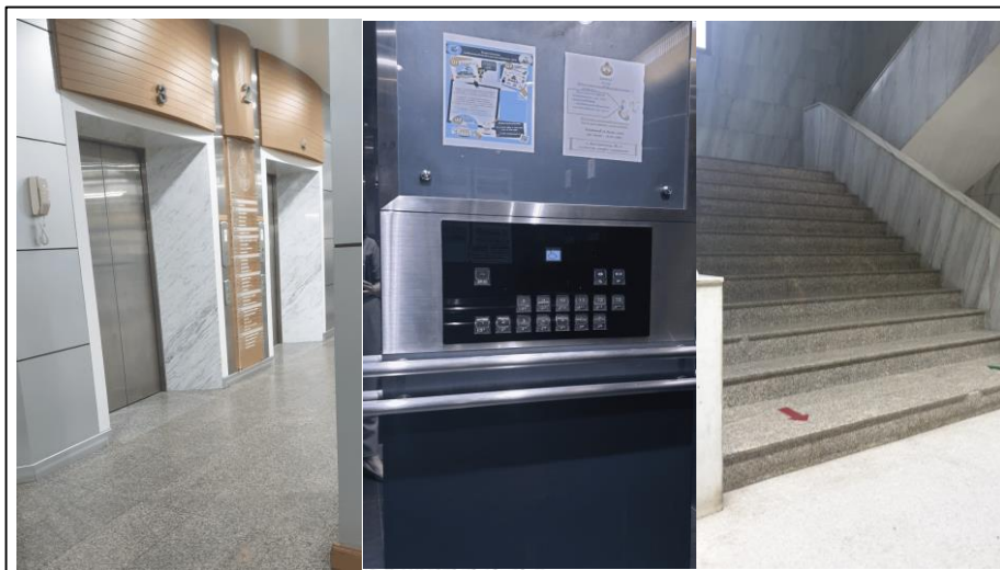
รูปภาพที่ 19 บริเวณลิฟต์โดยสารและบันได
