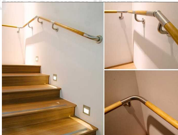
รูปภาพที่ 55 ตัวอย่างบันไดที่เหมาะสมสำหรับผู้สูงอายุ ที่มา: เข้าถึงได้โดย เว็บไซต์ https://www.scgbuildingmaterials.com/th/LivingIdea/Mainte เมื่อวันที่ 5 พ.ค. 2562.
