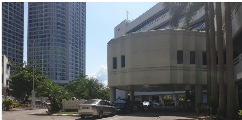
รูปภาพที่ 26 บริเวณภายนอกอาคารสำนักงานอัยการสูงสุด อาคารกรุงเทพใต้
