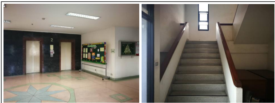
รูปภาพที่ 33 บริเวณโถงลิฟต์โดยสารและบันได
