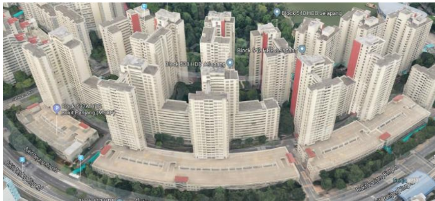
ภาพ 101 แสดงอาคารจอดรถแนวยาว ที่ถูกวางชิดกับขอบเขตที่ดิน
