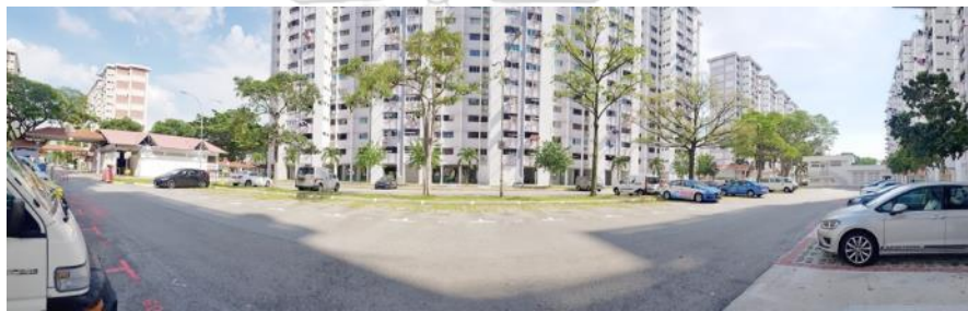
ภาพ 22 ลานจอดรถซึ่งเป็นส่วนหนึ่งกับถนนภายในโครงการ บนพื้นที่โล่งระหว่างอาคาร 2 แถว
