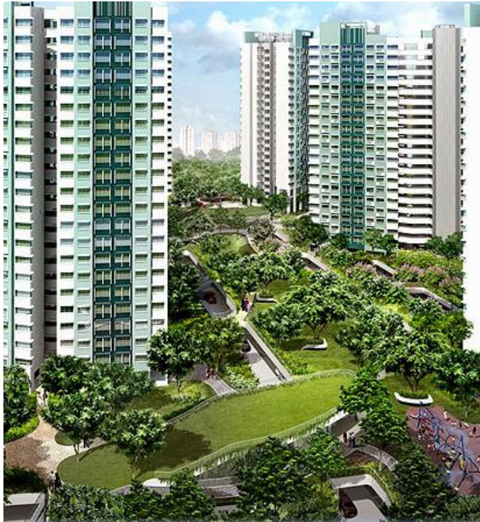
ภาพ 146 แสดงพื้นที่เปิดโล่งผืนใหญ่ที่เชื่อมทุกอาคารเข้าด้วยกันอย่างไม่มีอุปสรรคในการเข้าถึง
