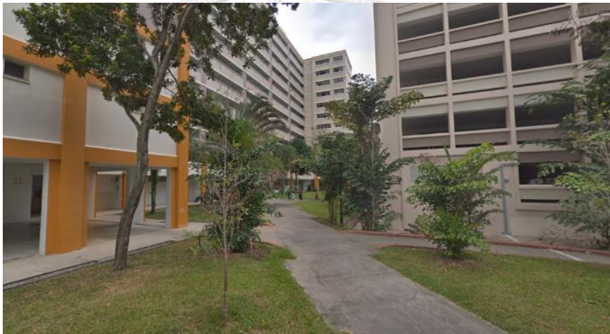
ภาพ 96 แสดงพื้นที่เปิดโล่งระหว่างอาคาร แทนที่ลานจอดรถ ที่มา: http://www.google.com/maps [2 กุมภาพันธ์ 2562]
