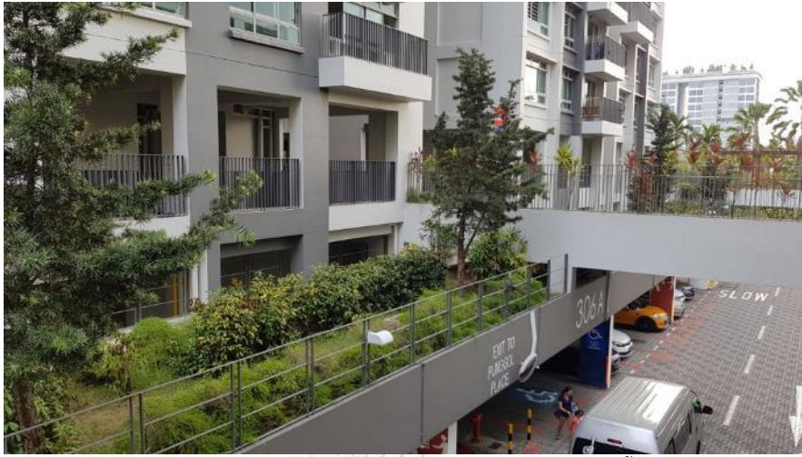
ภาพ 135 แสดงหลังคาที่จอดรถส่วนที่ไม่สามารถเข้าถึงได้ ถูกจัดเป็นพื้นที่สีเขียว
