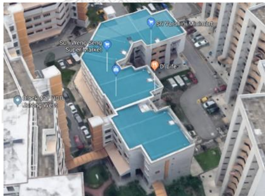
ภาพ 31 อาคารที่มีความสูง 4 ชั้นเท่ากันทั้งอาคาร ที่มา: https://www.google.com/maps [2 กุมภาพันธ์ 2562]
