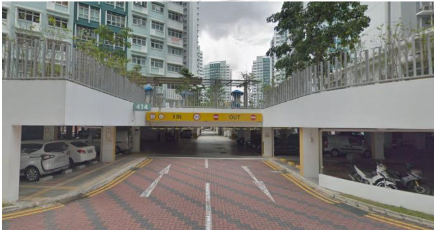
ภาพ 143 แสดงทางเข้าที่จอดรถกึ่งใต้ดิน ที่ขยับลึกเข้ามาหาพื้นที่โครงการ เนื่องจากระดับที่ต่างกันของพื้นที่โครงการ ที่มา: http://www.google.com/maps [2 กุมภาพันธ์ 2562]
