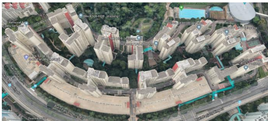
ภาพ 100 แสดงการวางอาคารชิดขอบที่ดินมีระยะห่างระหว่างอาคารเท่า ๆ กัน เกิดพื้นที่โล่งที่กลางโครงการที่เชื่อมทุกอาคารเข้าด้วยกัน
