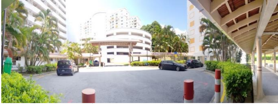
ภาพ 13 แสดงถนนที่ตัดผ่านระหว่างคู่อาคาร เพื่อการเข้าถึงอาคาร และจอดรถ
