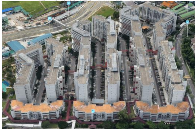
ภาพ 39 แสดงมุมมองจากทิศตะวันออกของโครงการ ที่มีอาคาร 4 ชั้นอยู่ด้านหน้า และอาคารสูงเป็นแนวยาว
