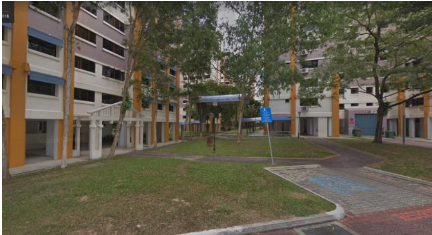
ภาพ 95 แสดงพื้นที่เปิดโล่งระหว่างอาคาร แทนที่ลานจอดรถ ที่มา: http://www.google.com/maps [2 กุมภาพันธ์ 2562]
