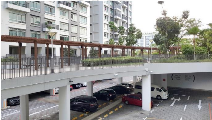
ภาพ 130 แสดงชั้นจอดรถ และสวนด้านบน
