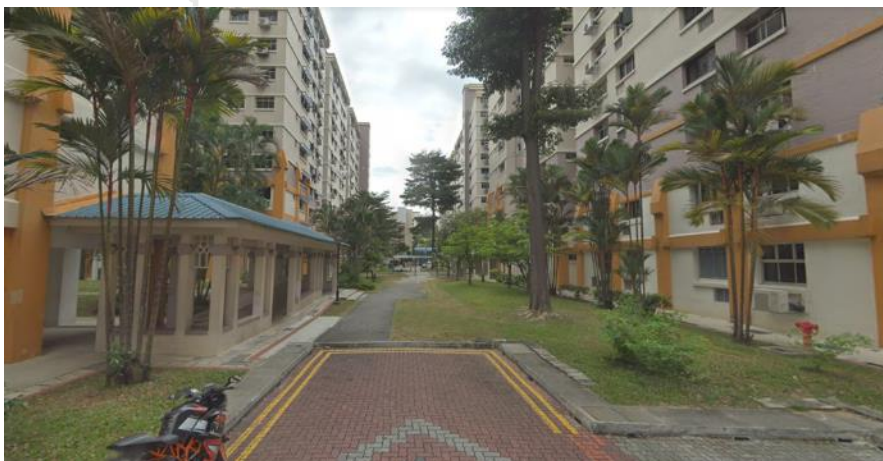
ภาพ 94 แสดงพื้นที่เปิดโล่งระหว่างอาคาร แทนที่ลานจอดรถ ที่มา: http://www.google.com/maps [2 กุมภาพันธ์ 2562]
