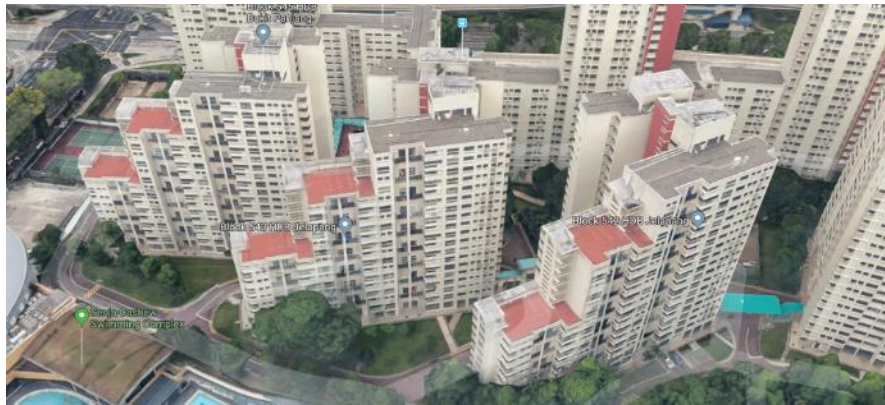
ภาพ 98 แสดงอาคารประเภท (1) ที่มีความสูงไม่เท่ากันภายในอาคาร ที่มา: http://www.google.com/maps [2 กุมภาพันธ์ 2562]
