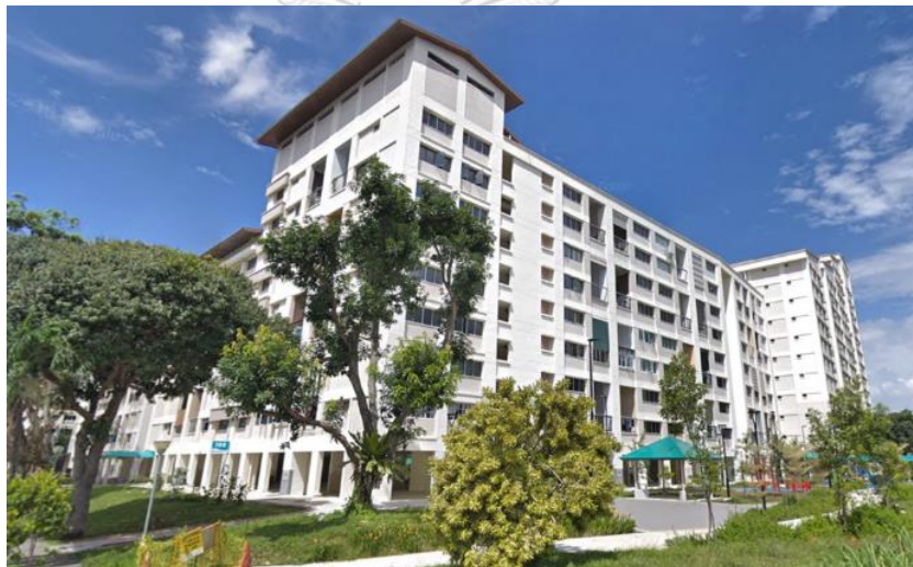
ภาพ 63 แสดงการจัดวางอาคารโดยให้ด้านยาวของอาคาร ขนานไปกับเขตที่ดิน ที่มา: http://www.google.com/maps [2 กุมภาพันธ์ 2562]
