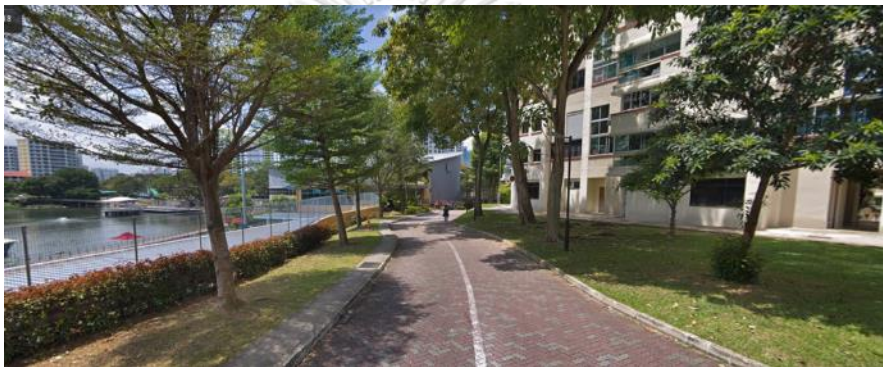
ภาพ 104 แสดงถนนภายในโครงการที่ถูกวางด้านนอกอาคารทั้งหมด ชิดกับขอบเขตที่ดิน ที่มา: http://www.google.com/maps [2 กุมภาพันธ์ 2562]
