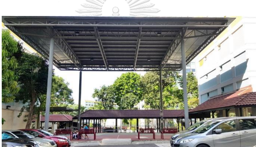
ภาพ 57 แสดงพื้นที่คอร์ทกึ่งฟ้า ภายใต้ศาลาอเนกประสงค์ ซึ่งตั้งอยู่ที่ปลายของถนน ระหว่างอาคาร จุฬาลงกรณ์มหาวิทยาลัย
