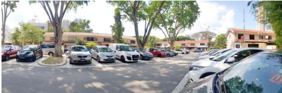
ภาพ 7 รูปถ่ายจากพื้นที่โครงการ แสดงลานจอดรถที่มีอาคารวางขนานโอบล้อม
