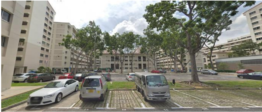
ภาพ 67 แสดงลานจอดรถ ซึ่งตั้งอยู่บนพื้นที่โล่งขนาดใหญ่กลางกลุ่มอาคาร โดยมีกระเบื้องต้นไม้ระหว่างแถวช่องจอด ที่มา: http://www.google.com/maps [2 กุมภาพันธ์ 2562]
