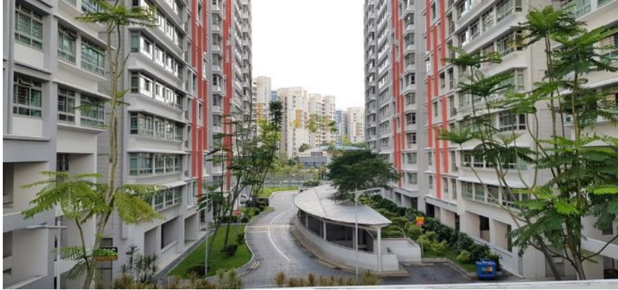
ภาพ 114 แสดงถนนภายในที่ตัดผ่านพื้นที่ระหว่างอาคาร เพื่อการเข้าถึงอาคาร
