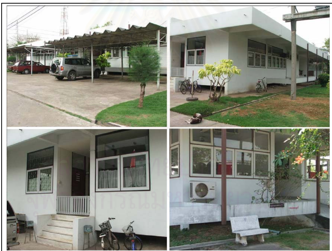
รูปภาพที่ 4.17 แสดงสภาพอาคารภายนอกอาคารหน่วยตรวจโรคที่ 12
