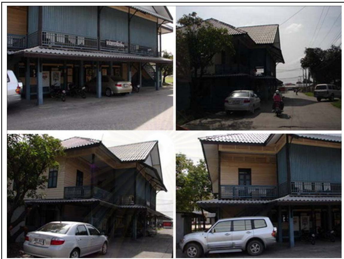
รูปภาพที่ 4.13 แสดงสภาพอาคารภายนอกอาคารหน่วยตรวจโรคที่ 10
