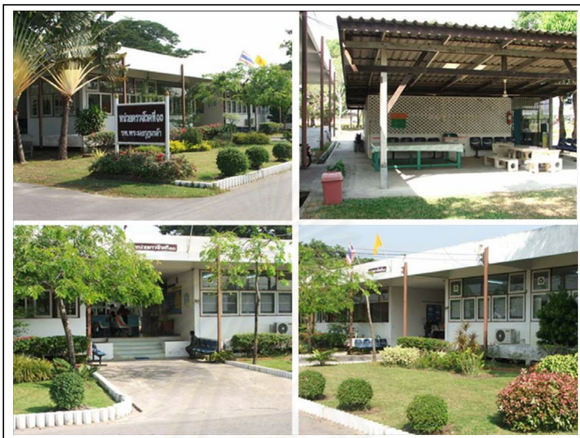
รูปภาพที่ 4.19 แสดงสภาพอาคารภายนอกอาคารหน่วยตรวจโรคที่ 13
