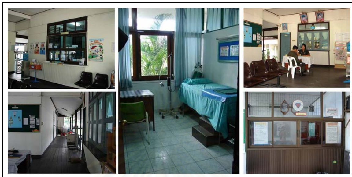
รูปภาพที่ 4.6 แสดงสภาพอาคารภายในอาคารหน่วยตรวจโรคที่ 5
