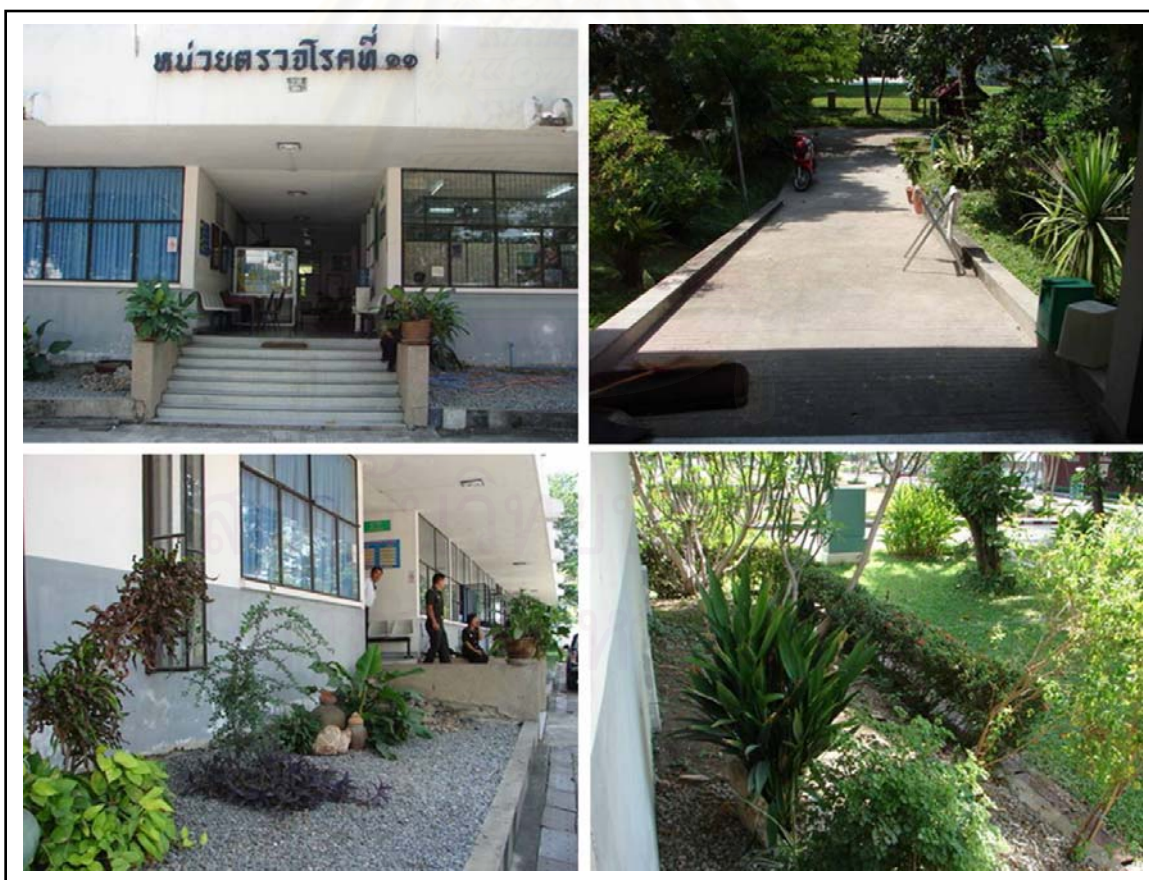
รูปภาพที่ 4.15 แสดงสภาพอาคารภายนอกอาคารหน่วยตรวจโรคที่ 11
