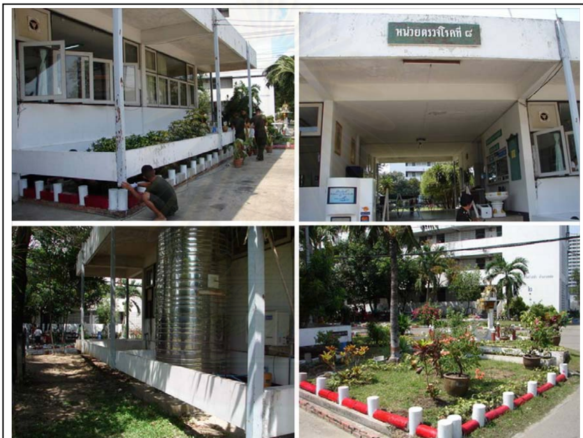
รูปภาพที่ 4.9 แสดงสภาพอาคารภายนอกอาคารหน่วยตรวจโรคที่ 8
