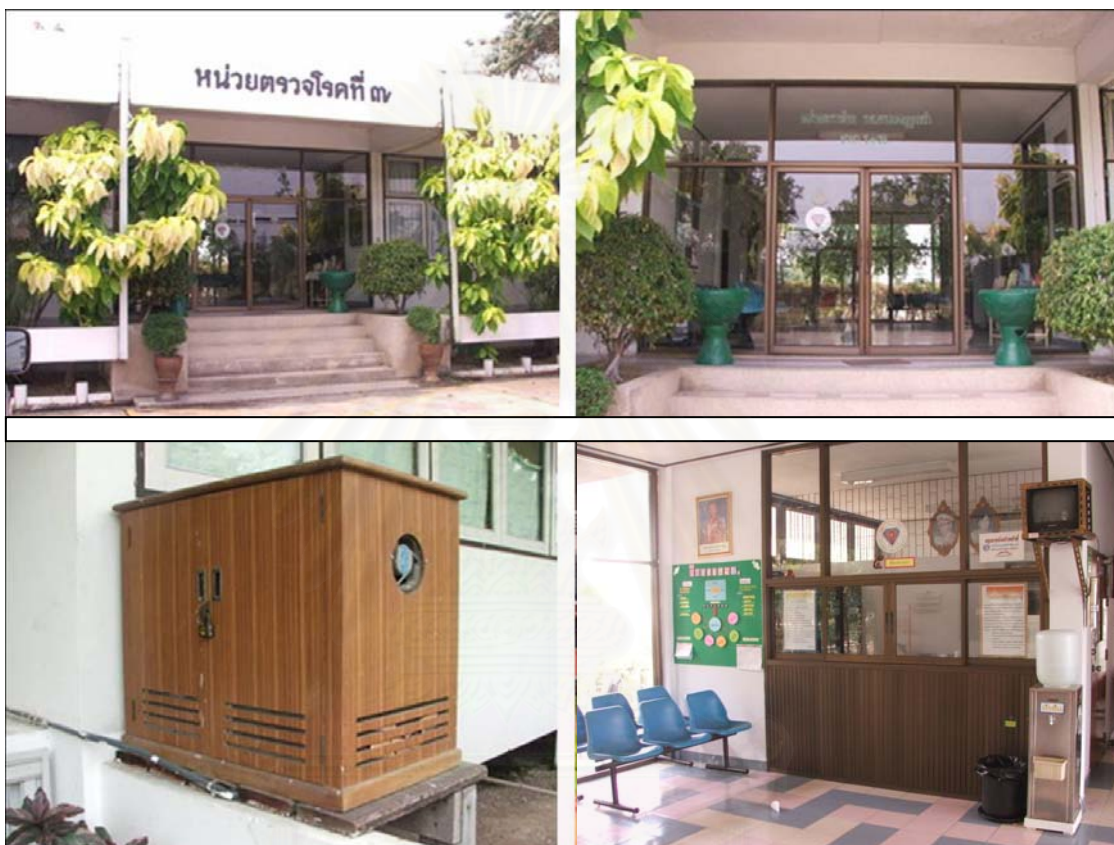
รูปภาพที่ 4.7 แสดงสภาพอาคารภายนอก อาคารหน่วยตรวจโรคที่ 7
