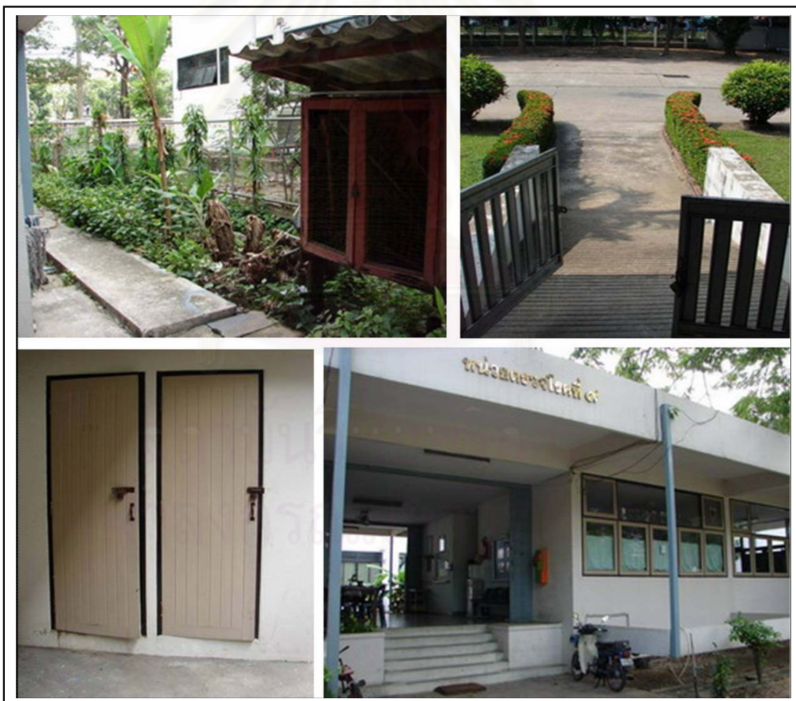
รูปภาพที่ 4.11 แสดงสภาพอาคารภายนอกอาคารหน่วยตรวจโรคที่ 9
