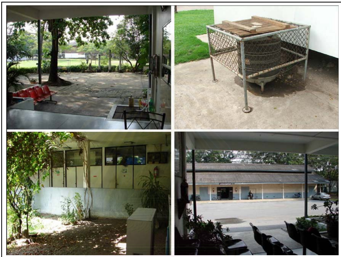
รูปภาพที่ 4.3 แสดงสภาพอาคารภายนอกอาคารหน่วยตรวจโรคที่ 4
