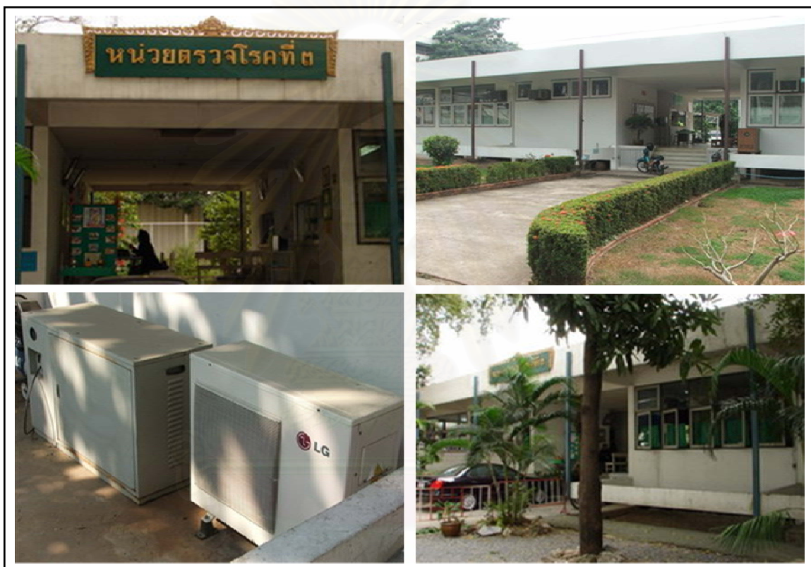
รูปภาพที่ 4.1 แสดงสภาพอาคารภายนอก อาคารหน่วยตรวจโรคที่ 3
