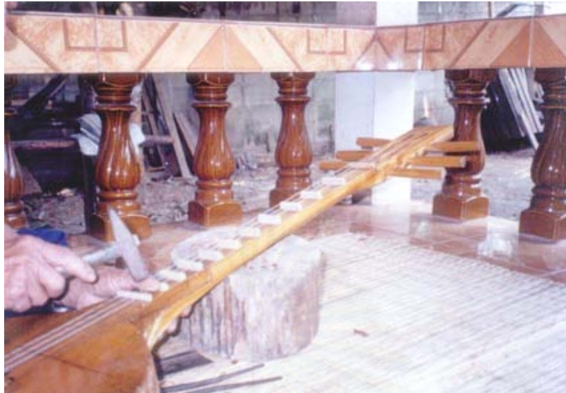
ภาพที่ 122 ติดลูกนับอันที่ 11
