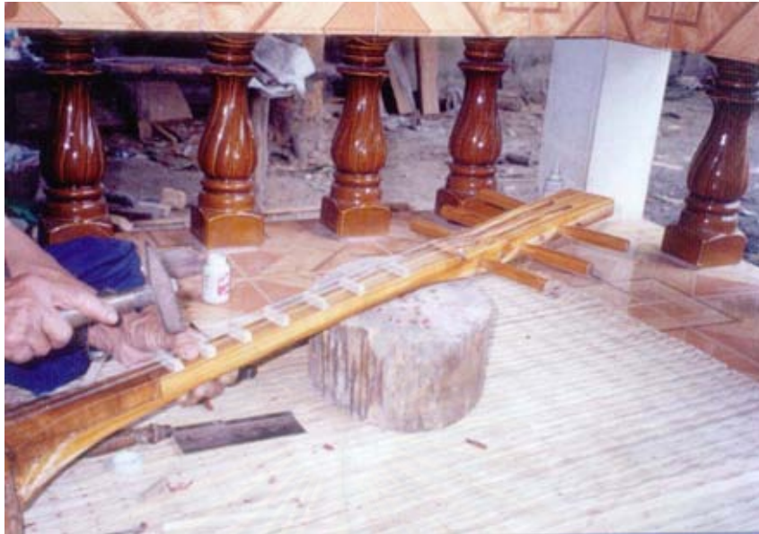
ภาพที่ 118 ติดลูกนับอันที่ 7
