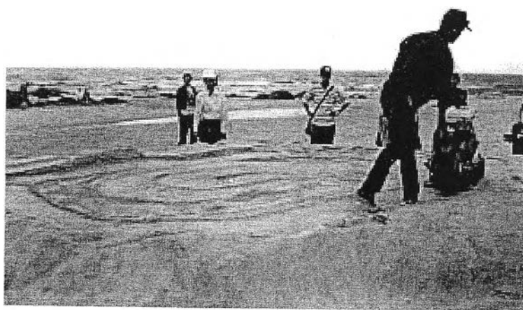
รูปที่ ก-3 การเตรียมฐานชั้นล่าง
