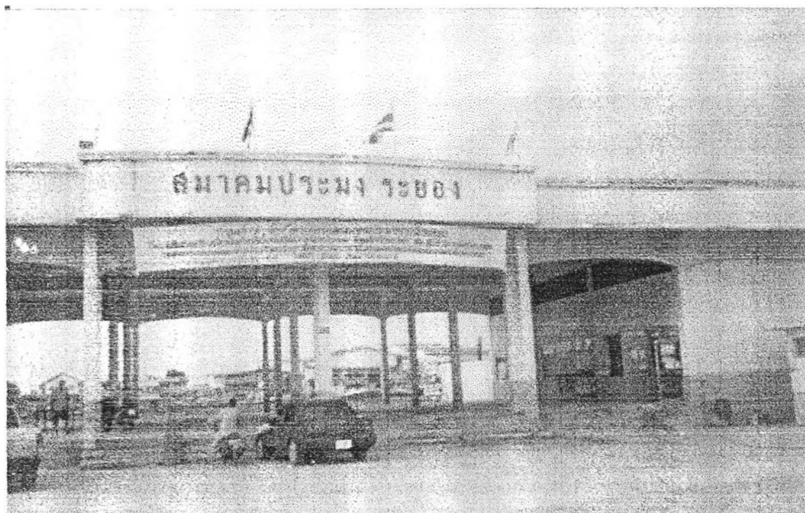
ภาพที่ 13 อาคารที่ทำการศูนย์การเรียนรู้ชุมชนสมาคมประมงระยอง
