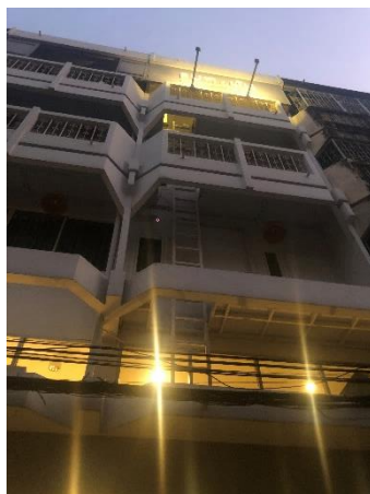
ภาพที่ 6.61 แสดงการเจาะพื้นระเบียงเดิมด้านหน้าอาคาร เพื่อติดตั้งบันไดหนีไฟภายนอกอาคาร
