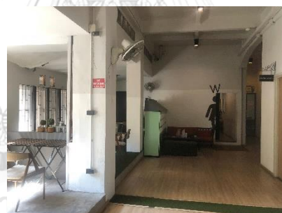
ภาพที่ 5.25 การปรับปรุงเสาคอนกรีตเดิมที่เป็นคอนกรีต ตัวอย่างกรณีโฮสเทล K
