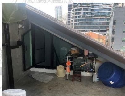
ภาพที่ 5.22 การเปลี่ยนโครงสร้างหลังคาบริเวณชั้นดาดฟ้า ตัวอย่างกรณีโฮสเทล C
