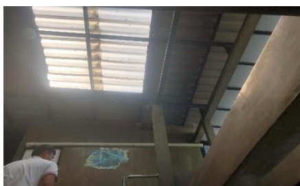
ภาพที่ 6.44 แสดงลักษณะของหลังคาและโครงสร้างที่ถูกซ่อมแซมจากของเดิมที่มีความชำรุดเนื่องจากอายุการใช้งานที่นานมาเป็นโครงสร้างที่แข็งแรง และเป็นวัสดุที่ทนไฟ จึงตรงตามข้อกำหนด
