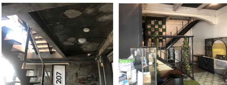
ภาพที่ 6.54 แสดงลักษณะเจาะพื้นอาคารเดิมเพื่อทำการติดตั้งบันไดหลักเข้าไปแทนบันไดเดิมเนื่องจากรวมคูหาตั้งแต่ 2 คูหาขึ้นไป จึงทำการรื้อบันไดเดิมออก และทำบันไดใหม่ตามการออกแบบและเพื่อเหมาะสมกับการใช้งาน
