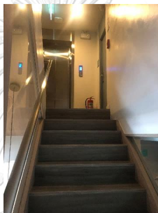
ภาพที่ 5.24 การทำบันไดหลักใหม่โดยเป็นโครงคอนกรีต ตัวอย่างกรณีโอสเทล G
