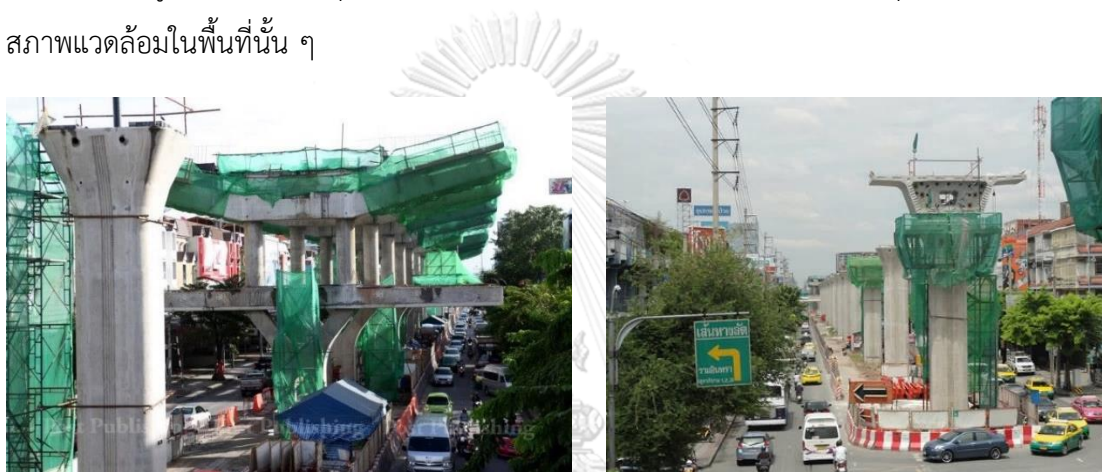
ภาพที่ 1.1 การก่อสร้างทางรถไฟฟ้ามานานชุมชนเมือง ที่มา : ผู้วิจัย
