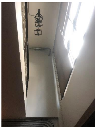
ภาพที่ 5.10 การเจาะพื้นเพื่อเพิ่มพื้นที่ในแนวดิ่งเพื่อเปิดรับแสงจากภายนอก ตัวอย่างกรณีโฮสเทล C
