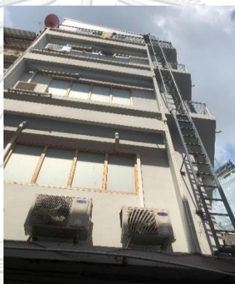
ภาพที่ 6.33 แสดงการติดตั้งบันไดหนีไฟภายนอกในรูปแบบที่เป็นบันไดแนวตั้ง(บันไดลิง)เพิ่มเข้าไปหลังจากที่ตัดแปลงอาคารเป็นโฮสเทล ไว้ในส่วนที่สามารถออกจากห้องพักได้เลยโดยไม่ต้องผ่านส่วนอื่น
