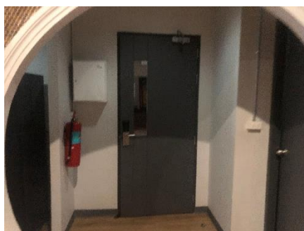
ภาพที่ 5.7 การทับผนังเพื่อเชื่อมพื้นที่ระหว่างคูหาอาคาร ตัวอย่างกรณีโฮสเทล H
