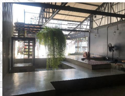
ภาพที่ 6.59 แสดงลักษณะการต่อเติมโครงสร้างเหล็กเพื่อรองรับการใช้งานบนชั้นตาดฟ้าอาคารและตามการออกแบบ
