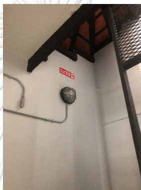
ภาพที่ 5.41 การติดตั้งป้ายทางออกฉุกเฉินที่เป็นป้ายแข็งบริเวณบันไดหลัก ตัวอย่างกรณีโฮสเทล C
