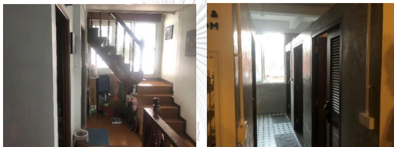
ภาพที่ 6.18 แสดงช่องแสงเดิมด้านหลังของอาคารที่สร้างก่อน พ.ศ. 2543 ที่ตั้งตำแหน่งกลาง แต่มีระยะห่างจากแนวเขตที่ดินไม่ถึง 3 เมตร ในชั้นที่ 3 ไม่ตรงตามข้อกำหนดกำหนดเนื่องจากกฎหมายกำหนดไว้ที่ 3 เมตร ในส่วนของช่องว่างของอาคารชั้นที่ 3 ขึ้นไป
