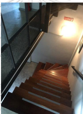
ภาพที่ 5.11 การเจาะพื้นเพื่อติดตั้งบันได ตัวอย่างกรณีโฮสเทล C
