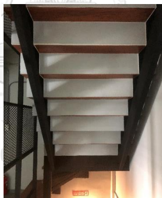
ภาพที่ 5.23 การทำบันไดหลักใหม่โดยเป็นโครงสร้างเหล็ก ตัวอย่างกรณีโฮสเทล C ที่มา : ผู้วิจัย
