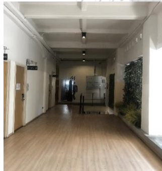
ภาพที่ 6.57 แสดงลักษณะทิวผนังที่กันระหว่างคูหาออกเนื่องจากเป็นการเชื่อมคูหาตั้งแต่ 2 คูหาขึ้นไป เพื่อปรับเปลี่ยนพื้นที่ภายในใหม่ตามการออกแบบและการใช้งาน
