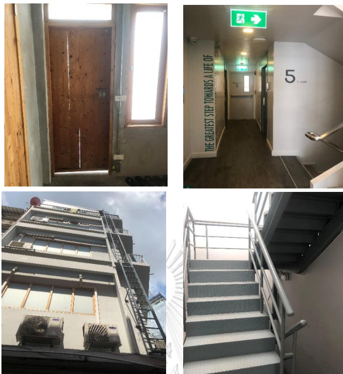
ภาพที่ 6.35 แสดงลักษณะของอาคารที่ตรงตามข้อกำหนด คือ มีประตูที่ปิดที่เป็นวัสดุทนไฟ บริเวณทางออก ไม่มี ธรณีประตูหรือสิ่งกีดขวางทาง และบันไดหนีไฟภายนอกติดตั้งไว้บริเวณผนังที่บ
