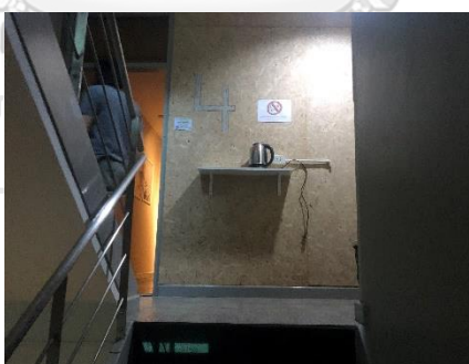
ภาพที่ 5.6 รูปแบบการกันผนังห้องโดยใช้โครงเคร่าผนังเบาในส่วนที่เป็นห้องพัก ตัวอย่างกรณีโฮสเทล J ที่มา : ผู้วิจัย
