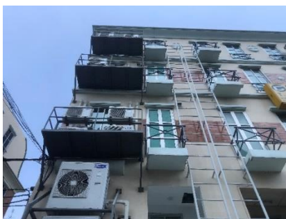
ภาพที่ 6.14 แสดงช่องแสงเดิมด้านข้างและด้านหลังของอาคารที่สร้างหลัง พ.ศ. 2543 ที่ตั้งบริเวณมุมที่อยู่ในชั้นที่ 3 ขึ้นไป มีระยะห่างจากแนวเขตที่ดิน 3 เมตรในชั้นที่ 3 ขึ้นไป ตรงตามข้อกำหนดเนื่องจากกฎหมายกำหนดไว้ที่ 3 เมตร ในส่วนของช่องว่างของอาคารชั้นที่ 3 ขึ้นไป
