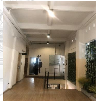
ภาพที่ 6.57 แสดงลักษณะทิวผนังที่กันระหว่างคูหาออกเนื่องจากเป็นการเชื่อมคูหาตั้งแต่ 2 คูหาขึ้นไป เพื่อปรับเปลี่ยนพื้นที่ภายในใหม่ตามการออกแบบและการใช้งาน
