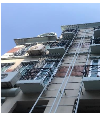
ภาพที่ 6.31 แสดงการติดตั้งบันไดหนีไฟภายนอกอาคารที่สร้างหลัง พ.ศ.2543 แบบแนวตั้งไว้ที่ด้านหลังของอาคารที่มีความสูง 4 ชั้น ตรงตามข้อกำหนดกำหนดเนื่องจากตัวอาคารมีความสูงไม่เกินกำหนดที่ 4 ชั้นของข้อกำหนดในการติดตั้งบันไดลิงที่ใช้หนีไฟภายนอกอาคาร ที่มา : ผู้วิจัย
