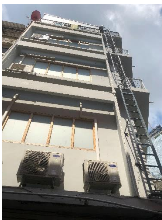
ภาพที่ 5.16 การติดตั้งบันไดหนีไฟภายนอกอาคารในลักษณะแนวดิ่ง(บันไดลิง) ตัวอย่างกรณีโฮสเทล A
