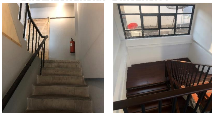
ภาพที่ 6.25 แสดงลักษณะของบันไดหลักที่ใช้เป็นบันไดหนีไฟภายในไม่ใช่แนวตั้ง และเป็นวัสดุที่มีความแข็งแรงและไม่ใช้วัสดุที่ก่อให้เกิดการลุกลามของเพลิงไหม้ ตรงตามข้อกำหนด
