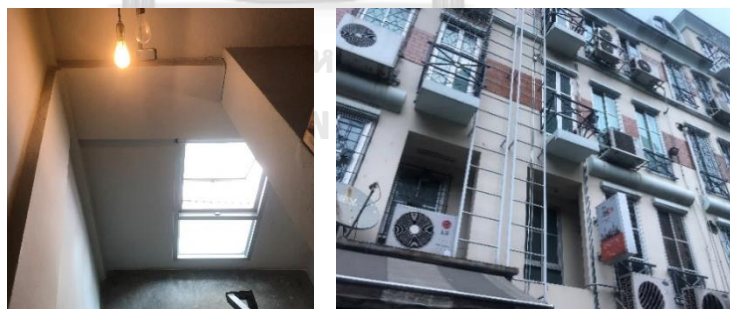
ภาพที่ 6.19 แสดงช่องแสงเดิมด้านหลังของอาคารที่สร้างหลัง พ.ศ. 2543 ที่ตั้งตำแหน่งกลาง แต่มีระยะห่างจากแนวเขตที่ดิน 3 เมตร ในชั้นที่ 3 ตรงตามข้อกำหนดกำหนดเนื่องจากกฎหมายกำหนดไว้ที่ 3 เมตร ในส่วนของช่องว่างของอาคารชั้นที่ 3 ขึ้นไป
