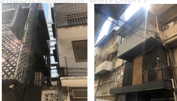
ภาพที่ 6.22 แสดงการตกแต่งผนังภายนอกด้วยการติดตั้งหน้ากากอาคาร (Facade) โดยมีระยะห่างไม่เกิน 1.20 เมตร จากผนังอาคาร ตรงตามข้อกำหนดกำหนดเนื่องจากไม่ได้ยื่นส่วนที่ติดตั้งเข้าไปในพื้นที่สาธารณะเกินที่ระยะกำหนดไว้ที่ 1.20 เมตร
