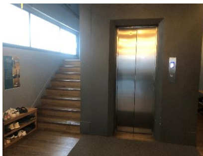
ภาพที่ 5.29 การติดตั้งลิฟต์โดยสารในอาคาร ตัวอย่างกรณีโฮสเทล E ที่มา : ผู้วิจัย
