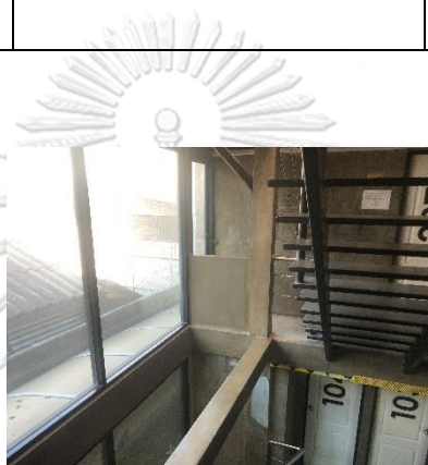
ภาพที่ 5.26 การปรับเปลี่ยนเสาโครงสร้างเดิมที่เป็นไม้มาเป็นคอนกรีต ตัวอย่างกรณีโฮสเทล L ที่มา : ผู้วิจัย
