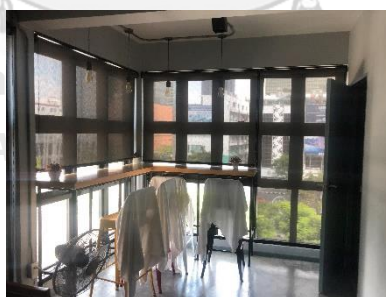
ภาพที่ 5.14 การดัดแปลงผนังภายนอกโดยการทุบผนังเก่าและติดตั้งกระจกเพิ่ม ตัวอย่างกรณีโอสเทล C ที่มา : ผู้วิจัย
