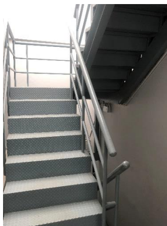
ภาพที่ 5.17 การติดตั้งบันไดหนีไฟภายนอกอาคารในลักษณะความลาดชันไม่เกิน 60 องศา ตัวอย่างกรณีโฮสเทล G ที่มา : ผู้วิจัย
