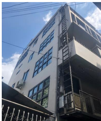
ภาพที่ 6.30 แสดงการติดตั้งบันไดหนีไฟภายนอกแบบแนวตั้งในแต่ละตำแหน่ง ในอาคารที่มีการต่อเติมพื้นที่ด้านหลังจะติดตั้งบันไดไว้พื้นที่ด้านหน้าหรือด้านข้างขึ้นอยู่กับตำแหน่งของอาคารนั้น และในอาคารที่มีพื้นที่ว่างด้านหลังจะติดตั้งไว้ที่ด้านหลังของอาคาร
