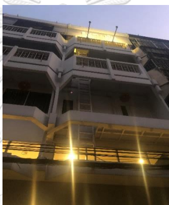
ภาพที่ 6.30 แสดงการติดตั้งบันไดหนีไฟภายนอกแบบแนวตั้งในแต่ละตำแหน่ง ในอาคารที่มีการต่อเติมพื้นที่ด้านหลังจะติดตั้งบันไดไว้พื้นที่ด้านหน้าหรือด้านข้างขึ้นอยู่กับตำแหน่งของอาคารนั้น และในอาคารที่มีพื้นที่ว่างด้านหลังจะติดตั้งไว้ที่ด้านหลังของอาคาร
