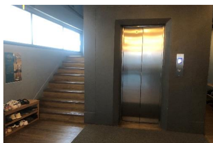
ภาพที่ 6.46 แสดงลักษณะการติดตั้งลิฟต์โดยสารภายในอาคาร โดยลิฟต์เป็นมาตรฐาน และผนังของช่องลิฟต์เป็นวัสดุทนไฟและมีพื้นที่โถงหน้าลิฟต์ในแต่ละชั้น ที่ 1.50 เมตร จึงตรงตามข้อกำหนด ที่มา : ผู้วิจัย
