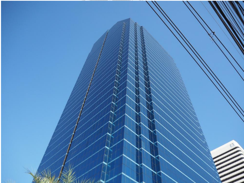
ภาพที่ 7.10 การสำรวจอาคารเลค รัชดา ออฟฟิศคอมเพล็กซ์
