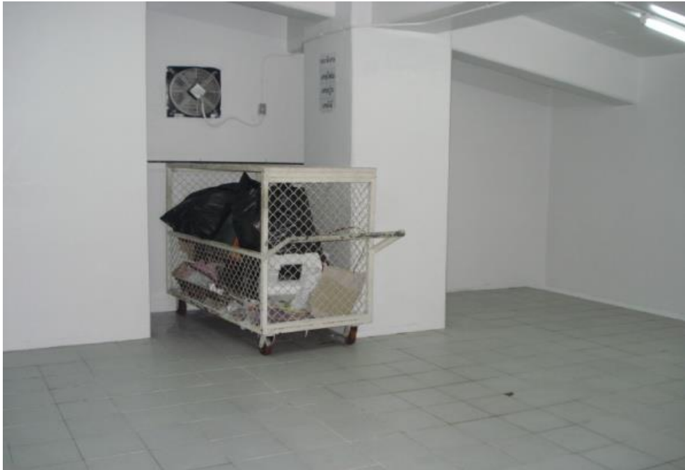
ภาพที่ 7.22 ห้องพักขยะอาคารชั้นทาวเวอร์ส
