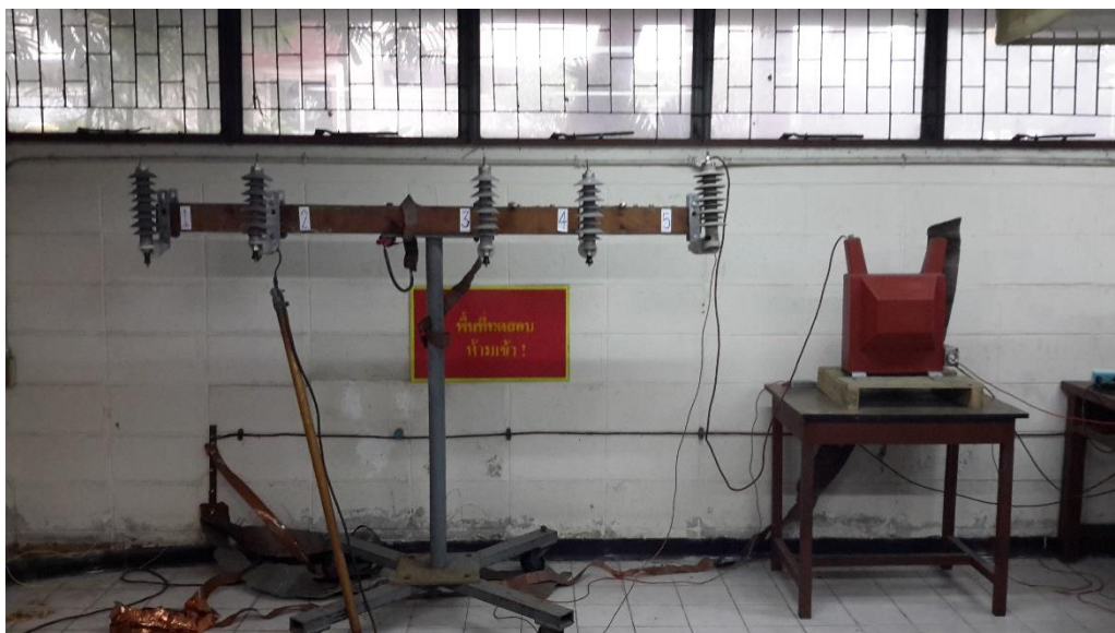
รูปที่ 3.7 การติดตั้งกับดักเสิร์จเพื่อทดสอบ
