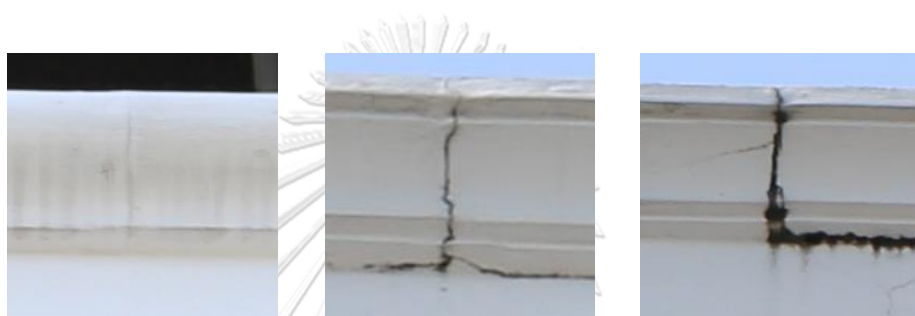
รูปที่ 4.20 ตัวอย่างขนาดความกว้างของรอยร้าว 0.5 1 และ 2 มิลลิเมตรที่ใช้เป็นเกณฑ์
