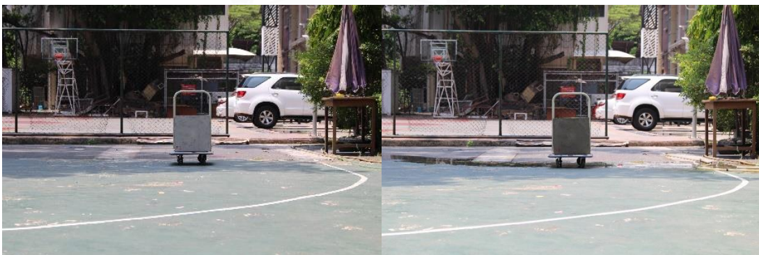
รูปที่ 4.5 ภาพถ่ายก่อนคอนกรีตเสริมเหล็กสถานะแห้งและเปียกที่ระยะ 10 เมตร
