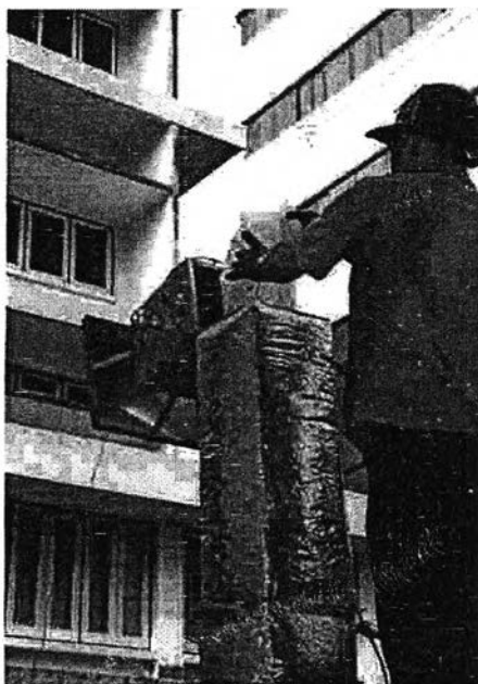
รูปที่ 7.23 แสดงการใส่เชื้อเพลิงหุ้มฉนวนถังน้ำร้อนลงในห้องอบลดความชื้น
