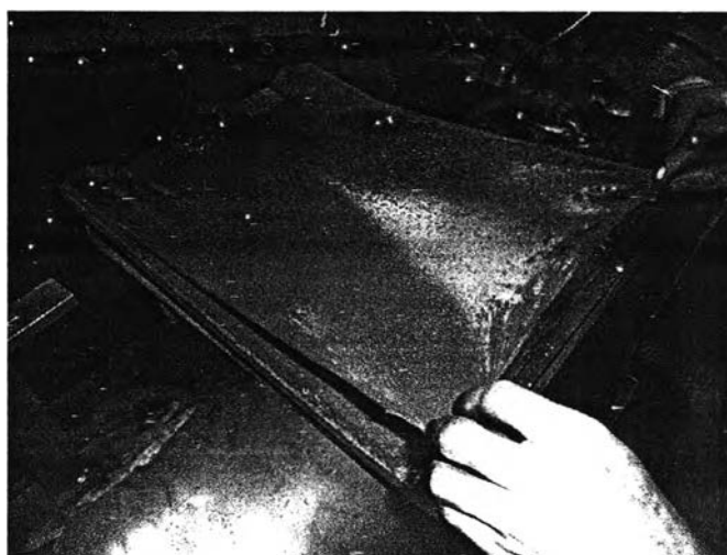
รูปที่ 4.47 แสดงวิธีการลอกฟิล์มน้ำยาเคลือบผิวกระเบื้อง
