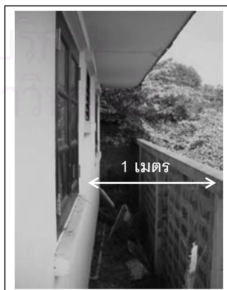
ภาพประกอบที่ 5.2 : แสดงระยะระหว่างเขตที่ดินกับผนังด้านที่มีช่องเปิดของบ้านหลังที่ 1 ที่ไม่ถูกต้องตามเทศบัญญัติ
