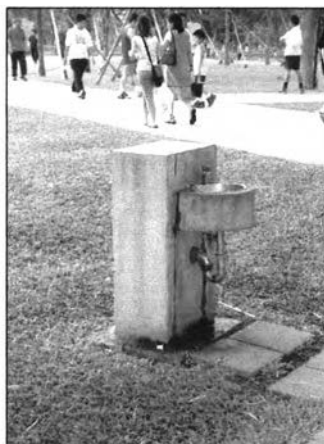
ภาพที่ 3.23 แสดงภาพลักษณะที่ดื่ม น้ำ สาธารณะ ถ่าย วันที่ 19 ตุลาคม
