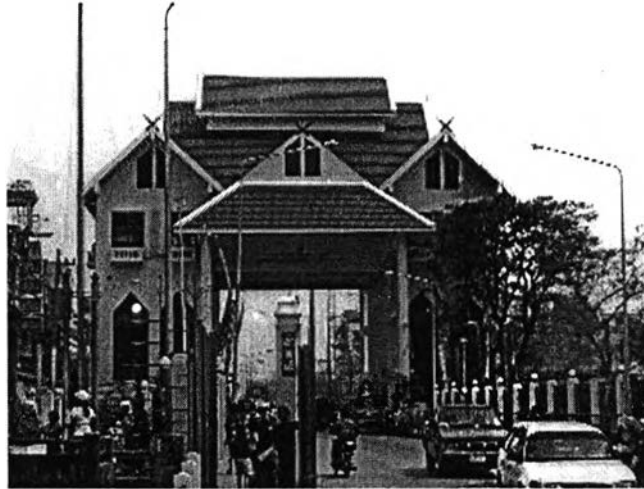
ภาพที่ 2 อาคารด่านศุลกากรและด่านตรวจคนเข้าเมือง อำเภอแม่สาย จังหวัดเชียงราย
