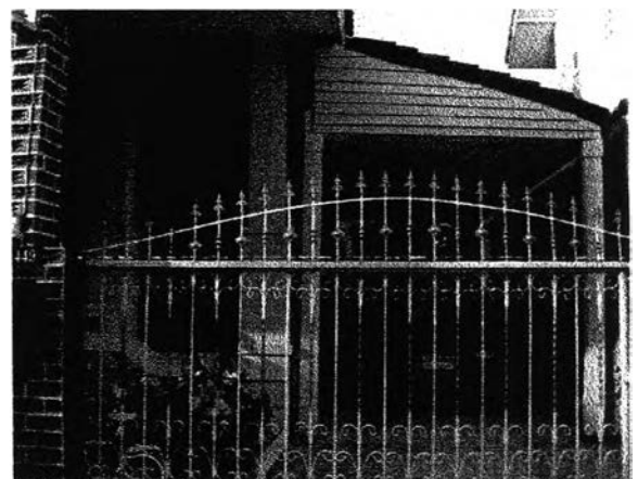
รูปที่ 5.14 แสดงรูปถ่ายการต่อเติมหลังคาด้านข้าง
