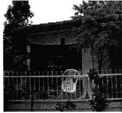
รูปที่ 5.24 แสดงรูปถ่ายการต่อเติมพื้นที่ ด้านข้างห้องรับแขก เป็นห้องนอนผู้สูงอายุ
