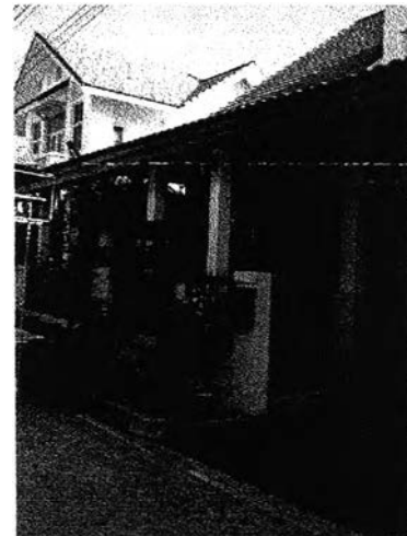
รูปที่ 5.10 แสดงภาพถ่ายการต่อเติม หลังคาที่จ่อตรงจนถึงแนวรั้ว โดยผืนหลังคาต่อเนื่องจากผืนเดิม
