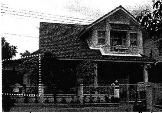
รูปที่ 5.23 แสดงรูปถ่ายการต่อเติมพื้นที่ ด้านข้างห้องรับแขก เป็นห้องนอนผู้สูงอายุ
