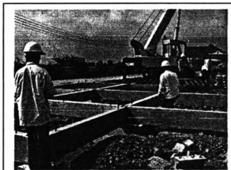
ภาพที่ 5.40 การติดตั้งคานคอดิน
