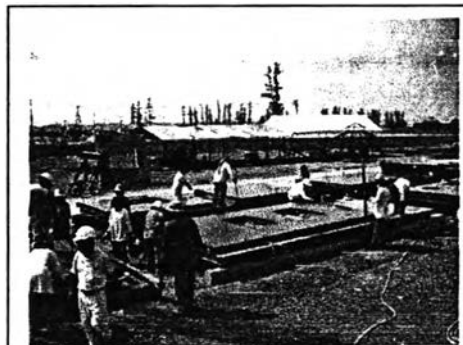
ภาพที่ 5.29 บ่มคอนกรีตด้วยผ้าใบคลุม
