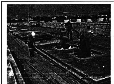
ภาพที่ 5.30 การถอดแบบข้าง
