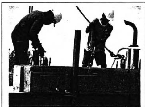
ภาพที่ 5.39 การนำคานมาติดตั้ง
