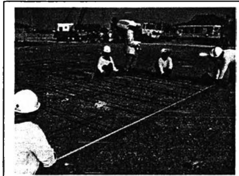
ภาพที่ 5.17 การผูกเหล็ก
