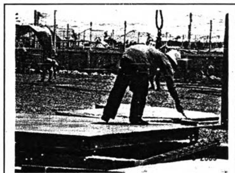
ภาพที่ 5.19 การทามันบนแบบเหล็ก
