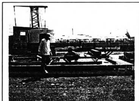
ภาพที่ 5.21 การประกอบแบบข้าง
