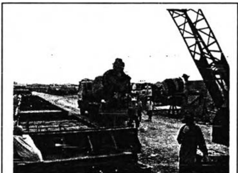
ภาพที่ 5.24 ใช้รถเข็นในการเทคอนกรีต
