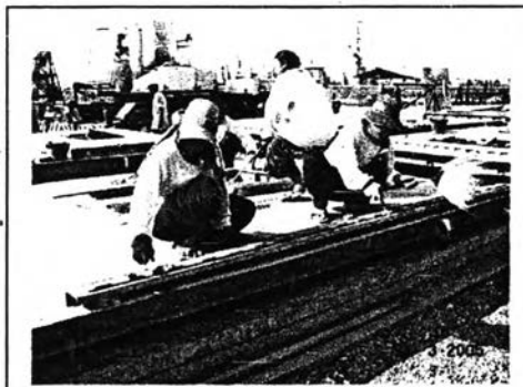
ภาพที่ 5.18 การล้างและเช็ดแบบ
