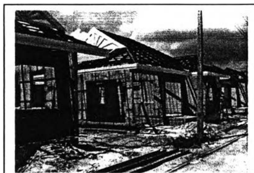
งานติดตั้งหลังคา จั่ว เเชิงชาย
