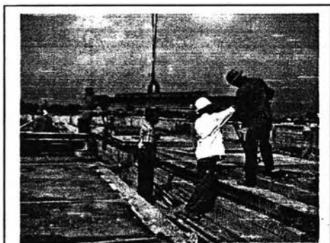
ภาพที่ 5.32 อุปกรณ์ยกชิ้นส่วนสำเร็จรูปผนัง
