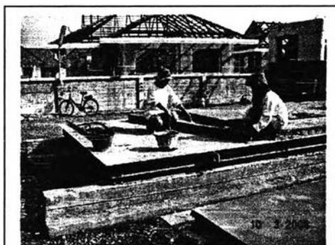
ภาพที่ 5.20 การเตรียมประกอบแบบเหล็กข้าง
