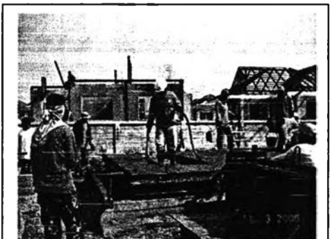
ภาพที่ 5.26 ใช้เครื่องจี้ปูนจี้คอนกรีต
