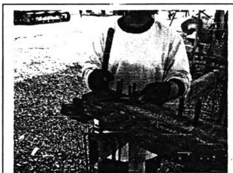
ภาพที่ 5.14 การผูกเหล็กคาน
