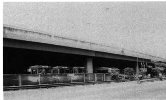
จุดจอดโดยสารบริเวณใต้ทางด่วน
