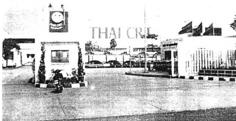
รูปที่ ข.5 โรงงานบริษัท ไทยซีอาร์ที้ จำกัด
