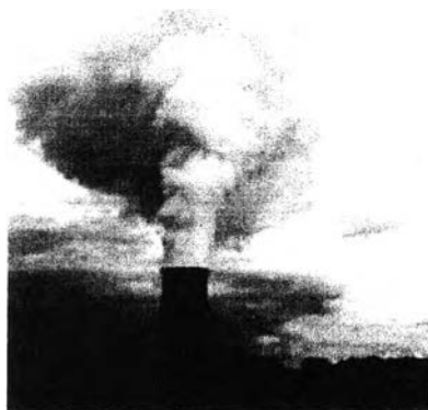
รูปที่ 1.1 การไหลแบบ Jet ใน Crossflow ที่เกิดจากการระบายอากาศเสียจากปล่องควัน
