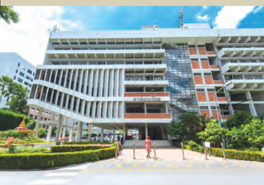
อาคารอานันทมหิดล
