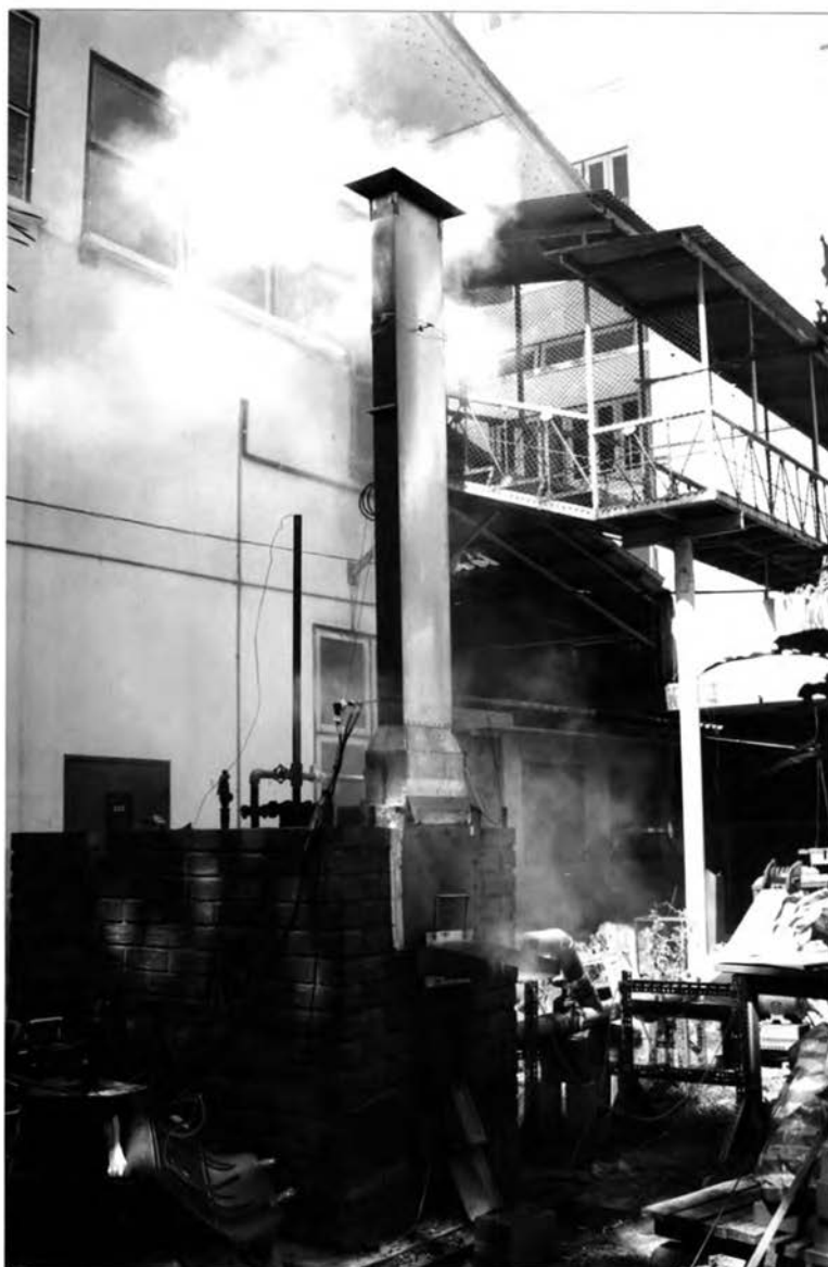
รูปที่ 6.16 (ต่อ) แสดงภาพถ่ายของควันที่ได้จากการเผาไหม้ที่ออกมาจากหม้อไอน้ำ
