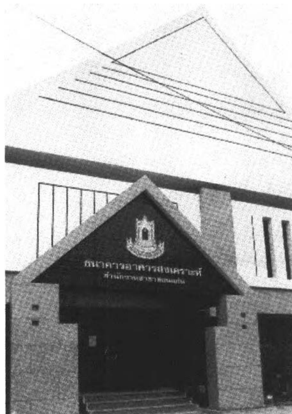
ภาพที่ 2.31 การใช้ผนังหินแกรนิตบริเวณทางเข้า อาคารสำนักงานสาขา ธนาคาร อาคารสงเคราะห์ ขอนแก่น
