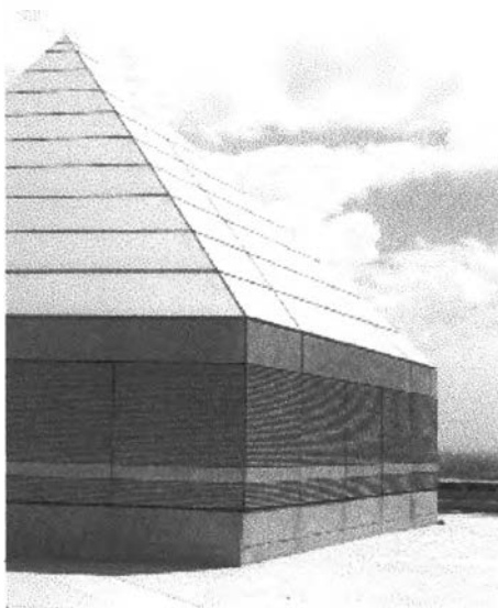
ภาพที่ 2.28 การใช้แผ่นผนังโลหะ (metal cladding) บนยอดอาคาร
