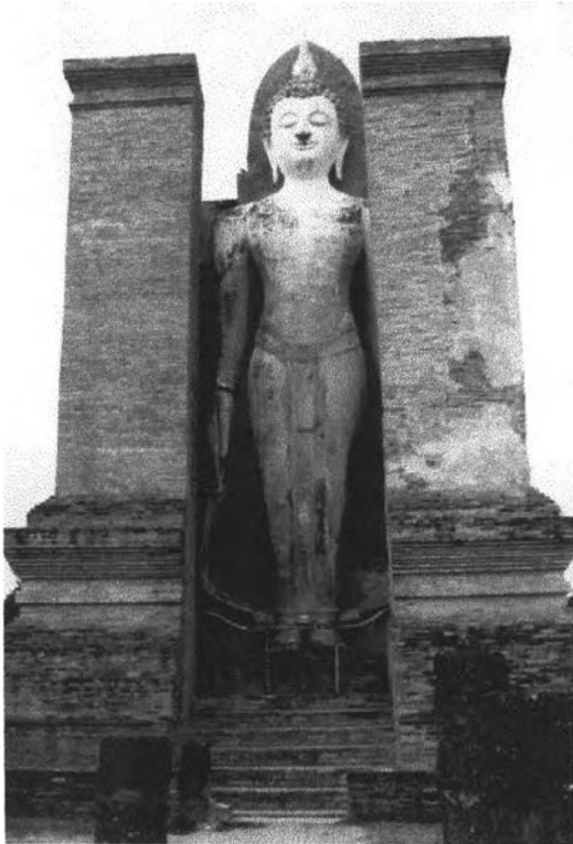
ภาพที่ 2.18 การหลุดร่อนของผิวปูน ทำให้เห็นการก่ออิฐข้างใน ซึ่งสามารถพบเห็นได้ทั่วไปตามโบราณสถาน
