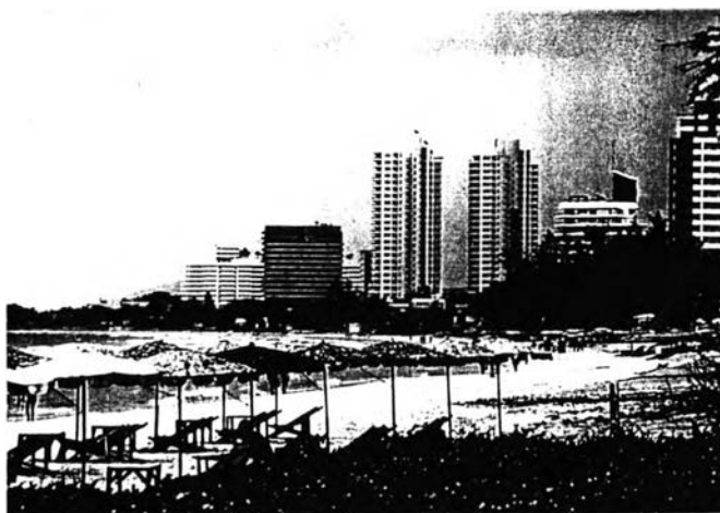
รูปที่ 3.14 อาคารสูงบริเวณชายหาดทางทิศใต้
