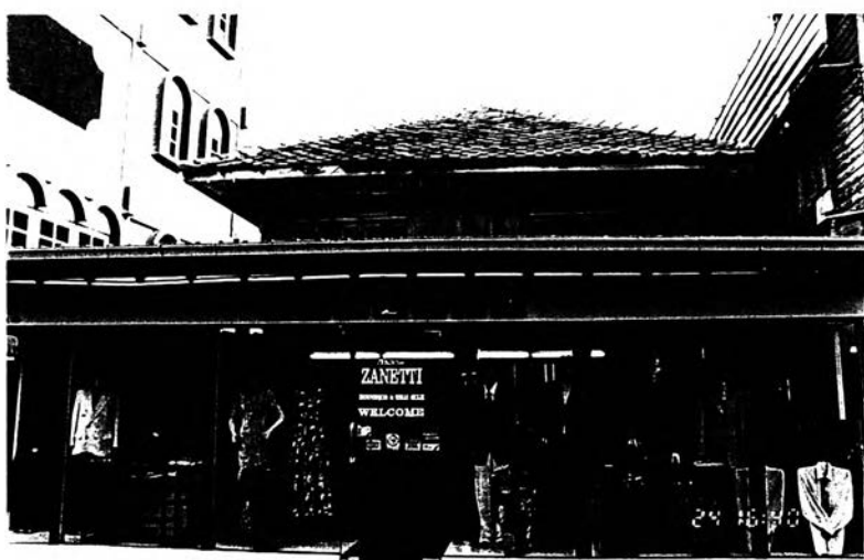
รูปที่ 5.23 ปัญหาอาคาร บริเวณถนนเรศดำริห์
