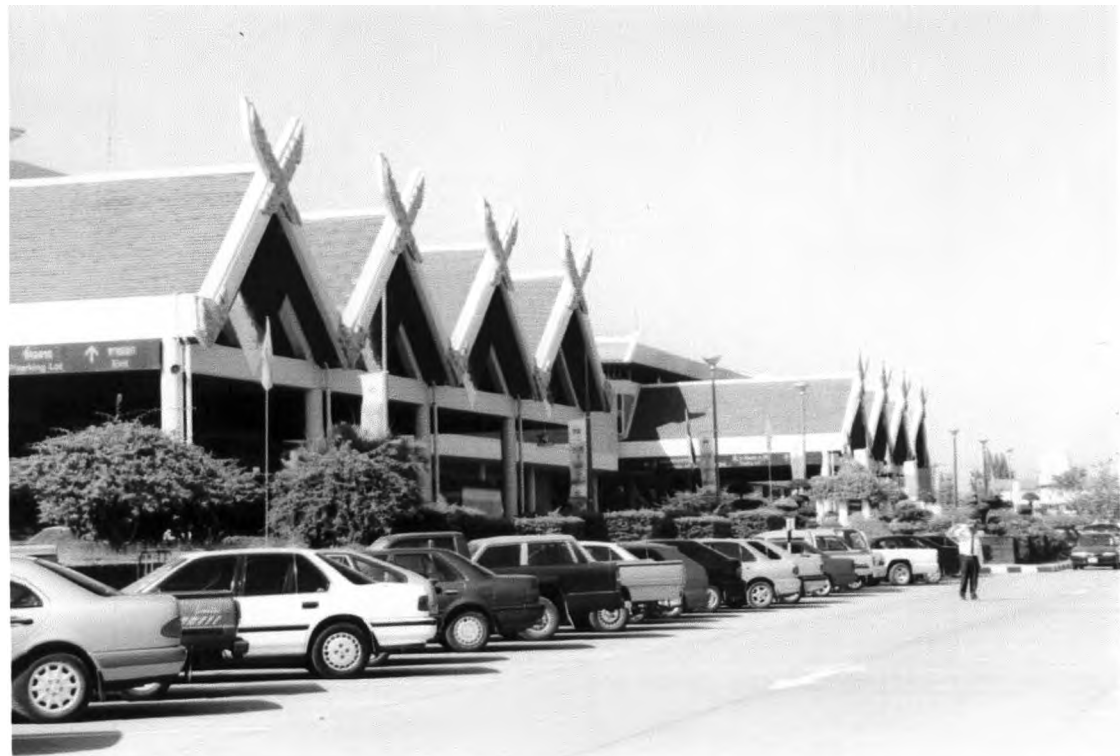
5.2 สนามบินจังหวัดเชียงใหม่ เชียงใหม่ แบบไม่มีชอคจั่วหลังคายื่นออกมา
