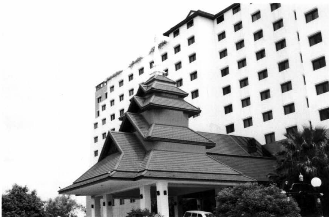
3.2 โรงแรมลิตเติ้ลค็อก เชียงราย แบบไม่มีหลังคาไขว้
