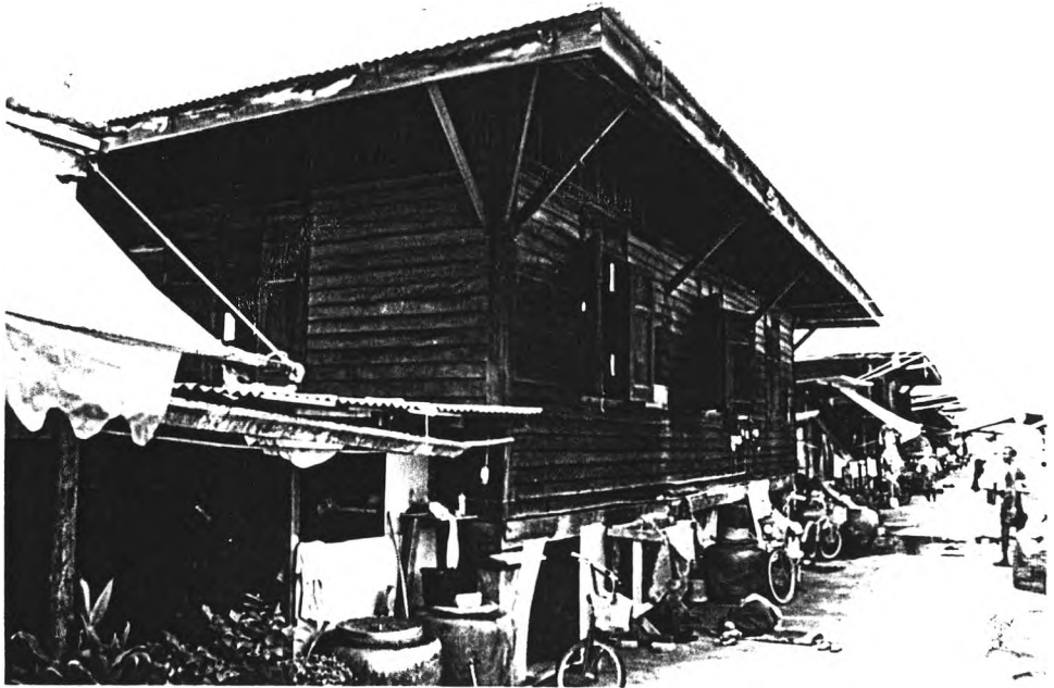
ภาพที่ 20 แสดงอาคารพักผู้ป่วยที่ 18 ซึ่งมีลักษณะเป็นอาคารบ้านเดี่ยว ใต้ถุนสูง
