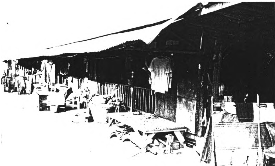
ภาพที่ 18 แสดงอาคารพักผู้ป่วยห้องแถว 20 ห้อง ซึ่งมีลักษณะเป็นอาคารไม้ ชั้นเดียวใต้ถุนต่ำ
