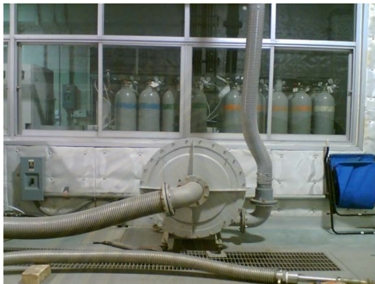
รูปที่ 4-33 แสดงภาพปั๊มดูดไอเสียออกนอกห้องทดลอง
