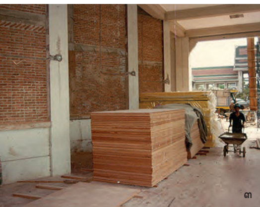
๓ บล็อกช่องลมที่ผนังระเบียง ถูกเปลี่ยนเป็นผนังก่ออิฐดิบเพื่อ รองรับการใช้เครื่องปรับอากาศ ในการบูรณะเมื่อปี พ.ศ. ๒๕๒๘
