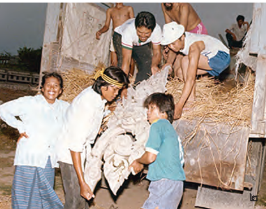
๒ การขนส่งชิ้นส่วนซุ้มลวดลายประดับ กรอบเวทีหล่อคอนกรีตมาติดตั้งที่ หอประชุม ในปี พ.ศ. ๒๕๒๘
