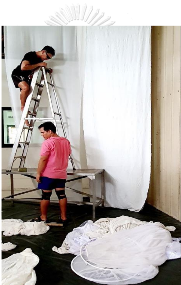
ภาพที่ 67 ภาพการจัดเตรียมอุปกรณ์ตกแต่งทำจากมุ้ง และร่มผ้าเคลือบน้ำมันขนาดใหญ่เข้ากับโครงสร้างอาคาร ที่มา: ผู้วิจัย
