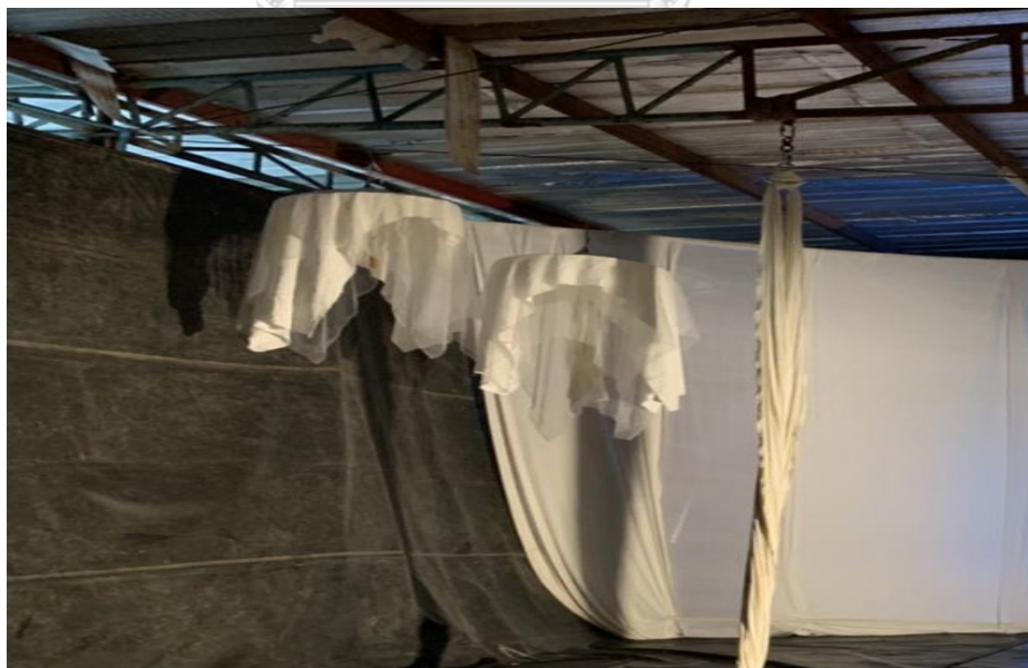
ภาพที่ 66 ภาพหลังการปฏิบัติการติดตั้งอุปกรณ์ตกแต่งทำจากร่มผ้าน้ำมันเข้ากับโครงสร้างอาคารสำเร็จ ที่มา: ผู้วิจัย
