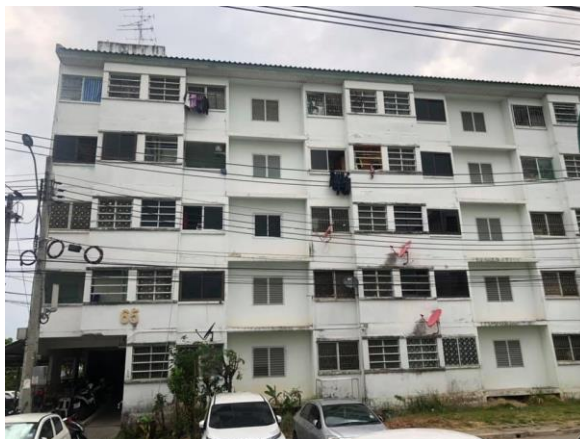
ภาพที่ 18 ภาพถ่ายอาคารชุดพักอาศัยนิติบุคคลบ้านเอื้ออาทรบึงกุ่ม นิติบุคคลที่ 3 ที่มา : จากการสำรวจ
