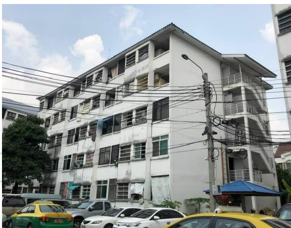
ภาพที่ 11 ภาพถ่ายอาคารชุดพักอาศัยนิติบุคคลบ้านเอื้ออาทรหัวหมาก
