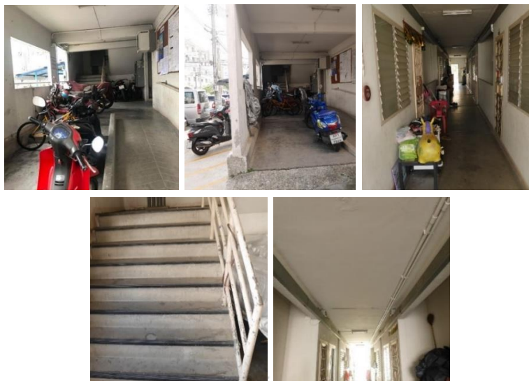
ภาพที่ 24 ตัวอย่างภาพถ่ายสภาพภายในบริเวณนิติบุคคลบ้านเอื้ออาทรบึงกุ่ม นิติบุคคลที่ 5 ที่มา : จากการสำรวจ
