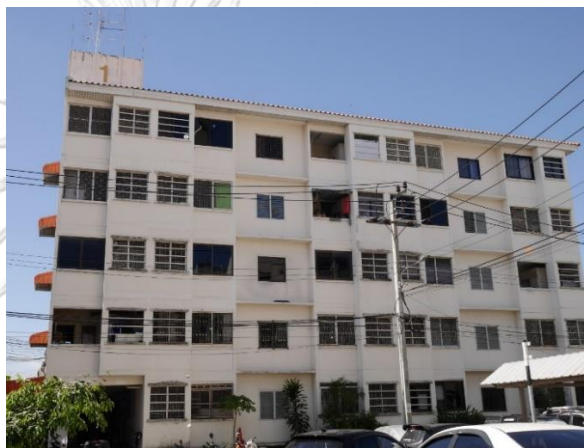
ภาพที่ 37 ภาพถ่ายอาคารชุดพักอาศัยนิติบุคคลบ้านเอื้ออาทรบึงกุ่ม นิติบุคคลที่ 1 ที่มา : จากการสำรวจ
