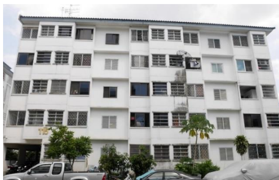
ภาพที่ 26 ภาพถ่ายอาคารชุดพักอาศัยนิติบุคคลบ้านเอื้ออาทรบึงกุ่ม นิติบุคคลที่ 6
