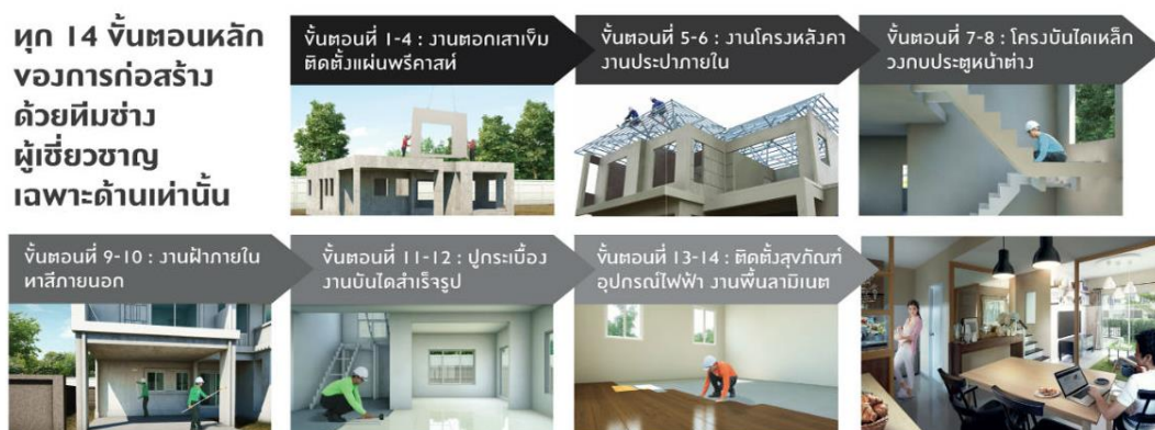
ภาพที่ 7 ระบบ REM 14 ขั้นตอนของการก่อสร้าง
