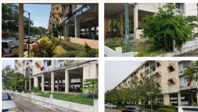
ภาพที่ 32 ทศนิยมภาพสวนด้านหน้าอาคาร
