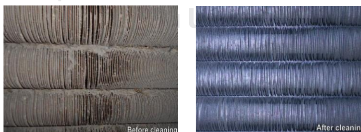
รูปที่ 3.5 ภาพก่อนและหลังการทำความสะอาดครีบบระบายความร้อน
