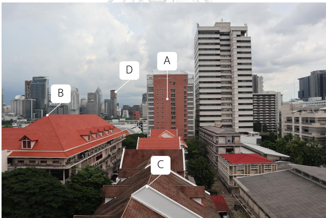
รูปที่ 47 ภาพถ่ายอาคารพร้อมตำแหน่งที่สนใจ
