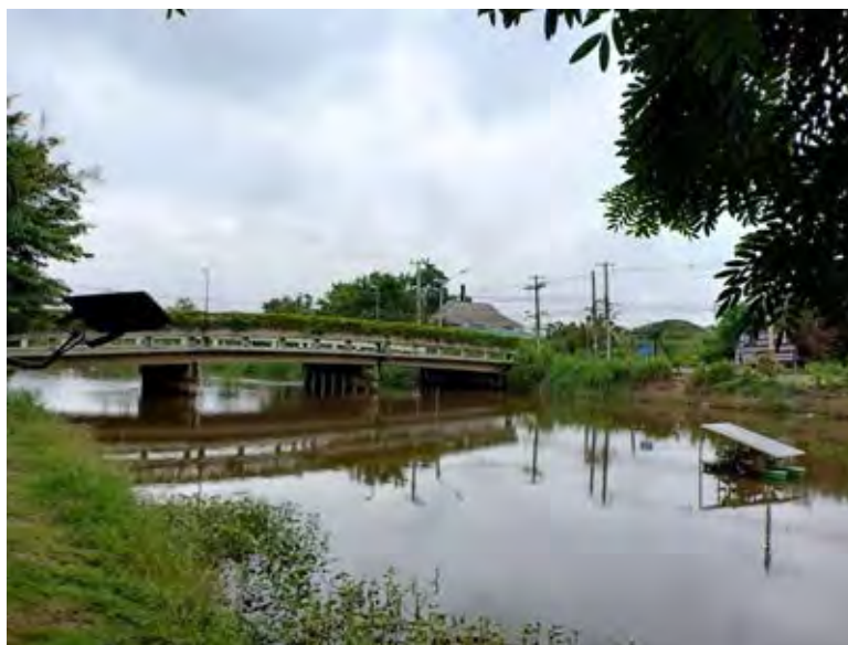
แผนภาพที่ 3.4.2 สภาพคลองในคลองสาม มีเครื่องบำบัดน้ำเสียตลอดคลอง
